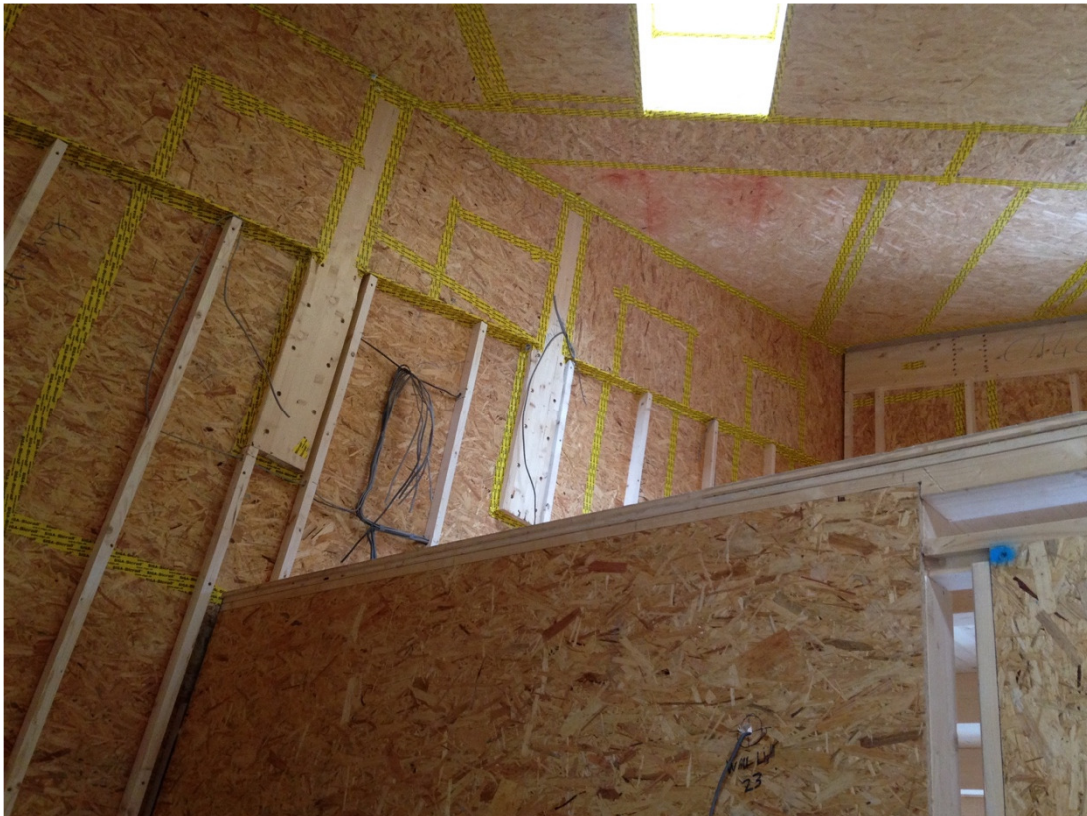
Taped Joints Party Wall and roof / abgeklebte Fugen Trennwand und Dach
