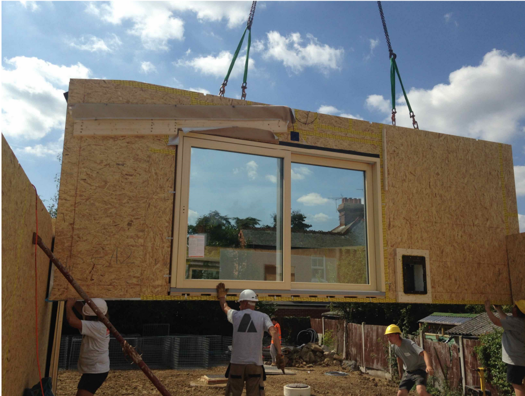
Sliding Door and Cat Flap / Schiebetür und Katzenklappe Haus II
