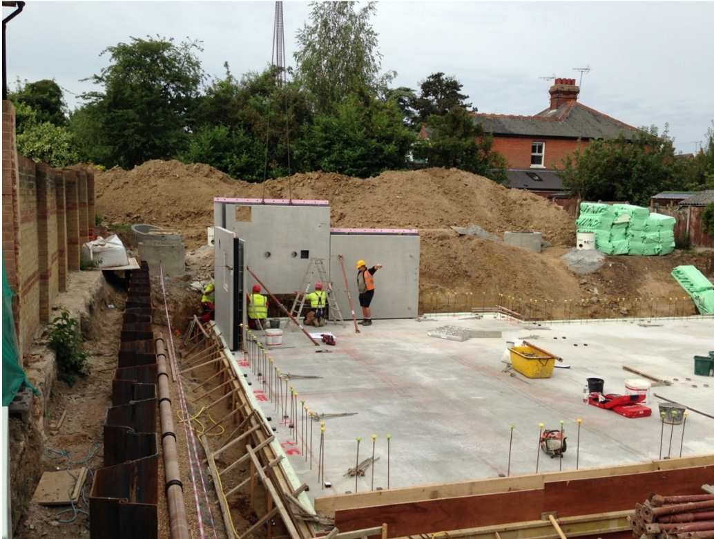
First external wall sections / erste Aussenwandteile Haus II
