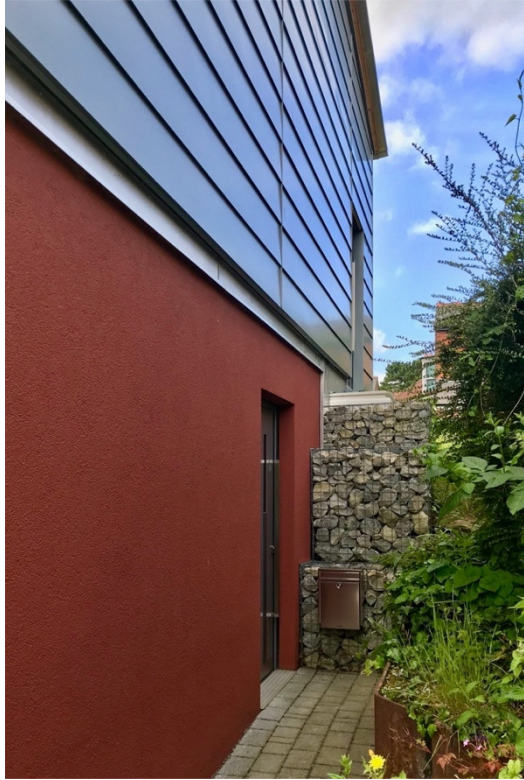
Haus I: Side Entrance to North-West / Seiteneingang nach Nord-Westen
