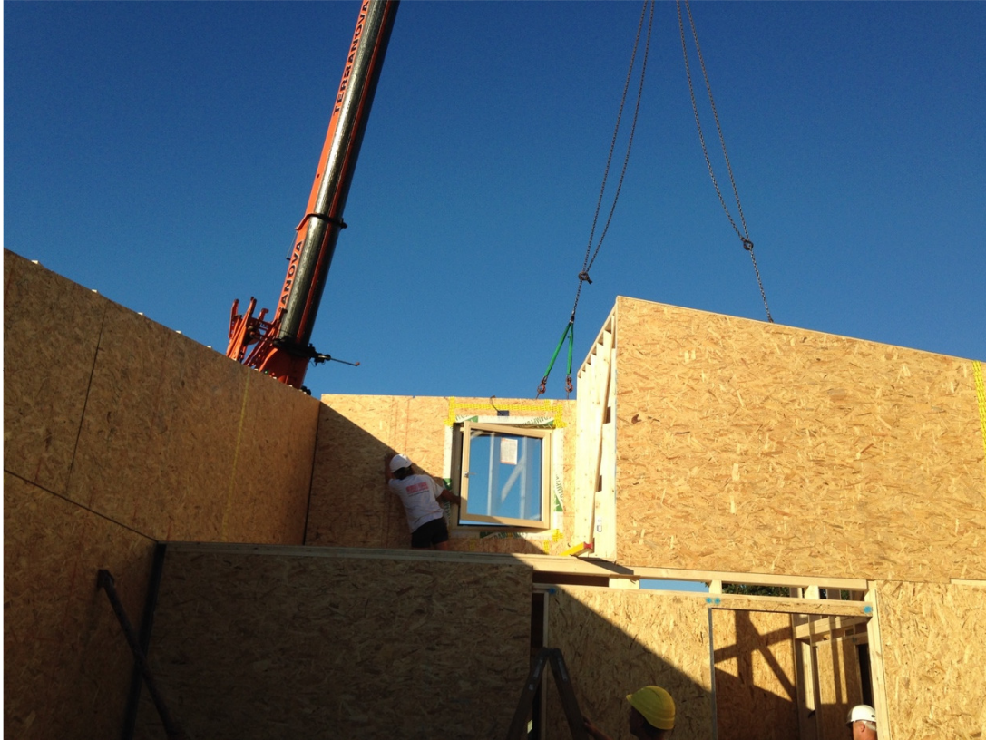
Last external wall section / letzter Aussenwandteil
