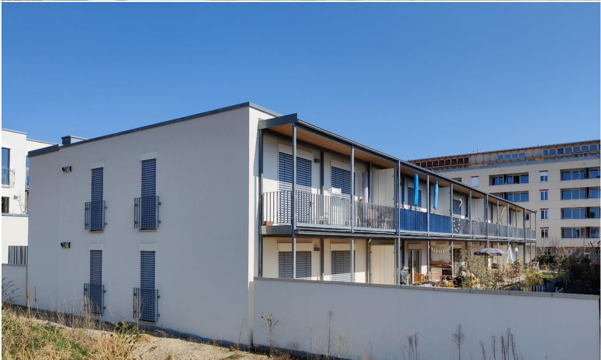
Views of the southwest with terraces & balconies to allow sufficient shading for the summer seasons. Aufnahme von Südwesten mit Terrassen und Balkonen, die ausreichend Schatten für die Sommermonate bieten.
