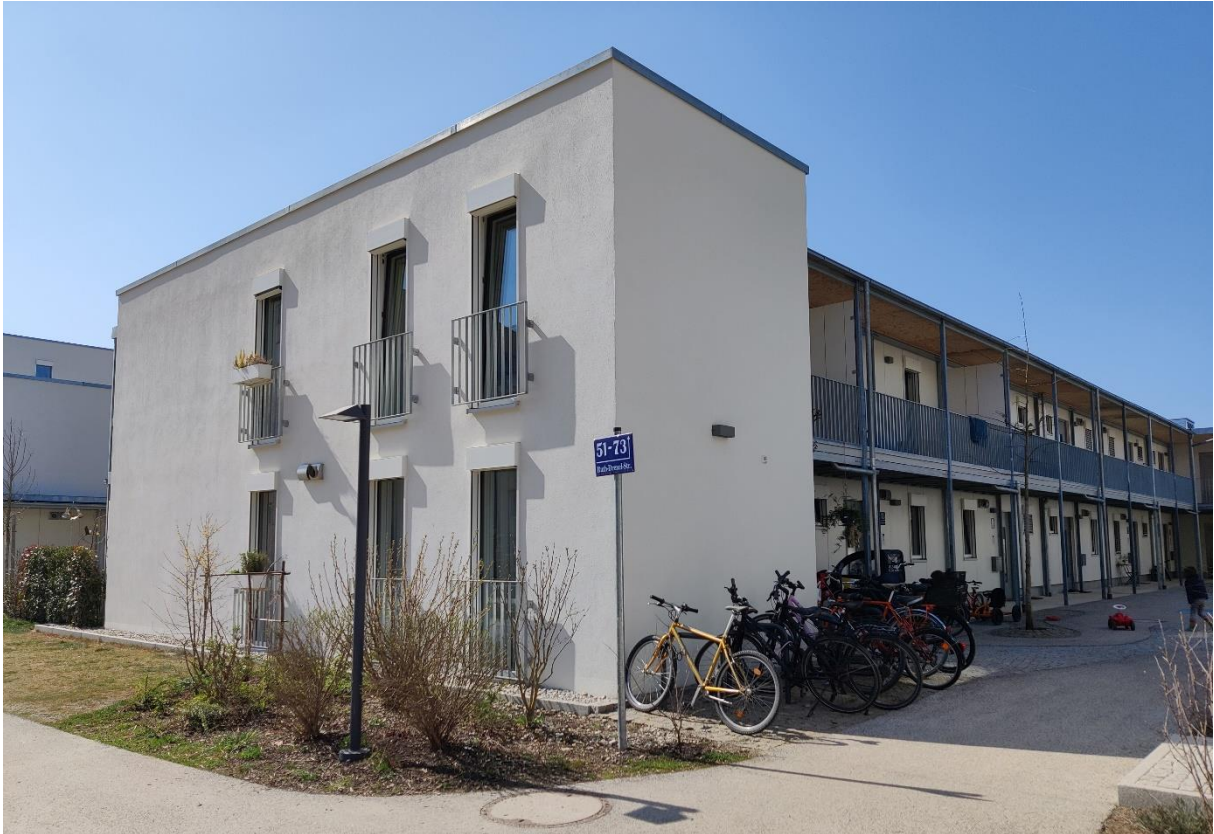
View of the northeast façade with entrances to the apartments. Ansicht der Nordost-Fassade mit den Eingängen zu den Wohnungen.
