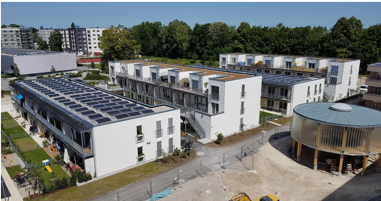
Aerial view of the southeast façade with PV-system on the flat roof. Luftansicht der Südost-Fassade mit PV-Anlage auf dem Flachdach.
