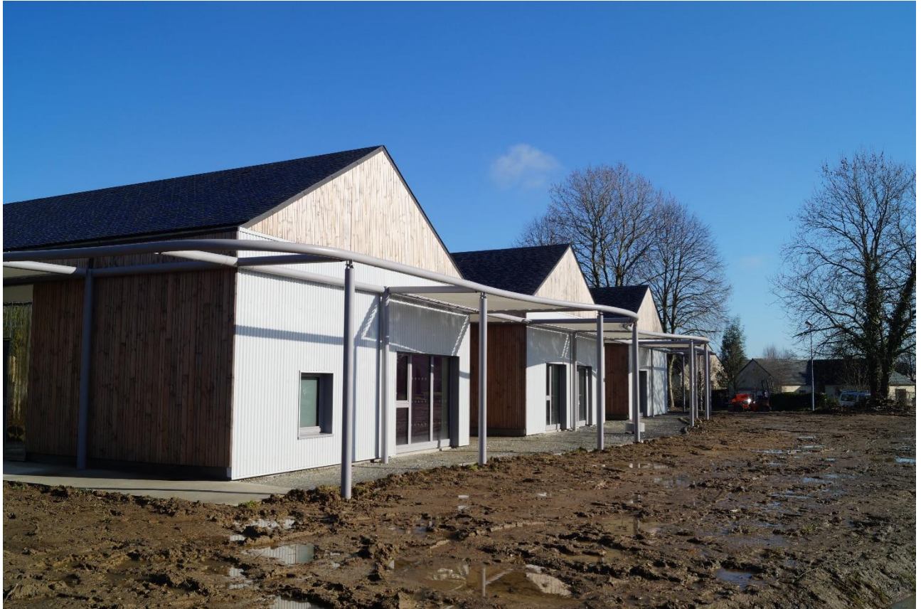
Figure 2 : Façade Sud Est
