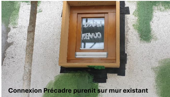
Châssis (vue intérieure sur Mur existant)
