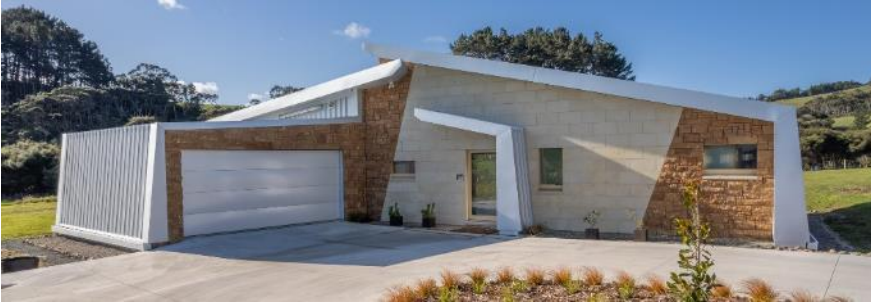
Entrance view - Southeast elevation Eingangsansicht - Südostansicht
