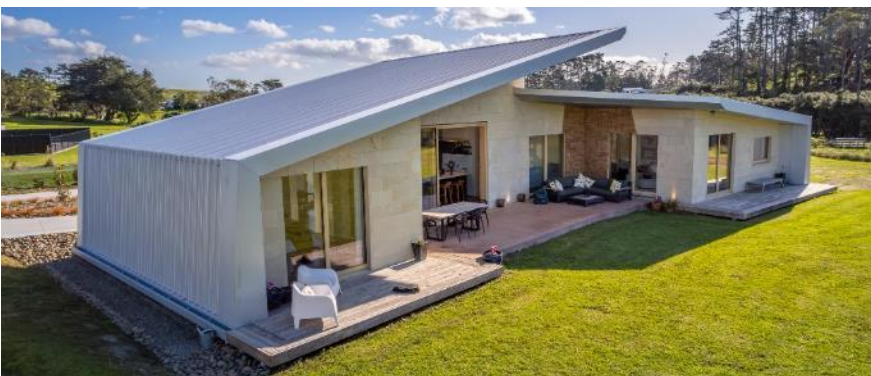
View of Master bedroom – Northeast view Blick auf das Hauptschlafzimmer – Nordostblick
