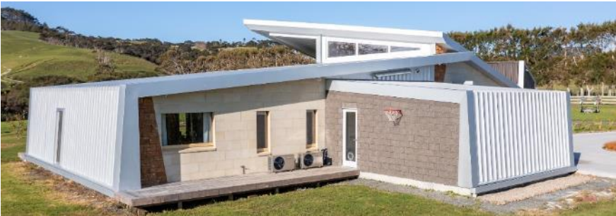
Back of garage – Southwest view Rückseite der Garage – Blick nach Südwesten
