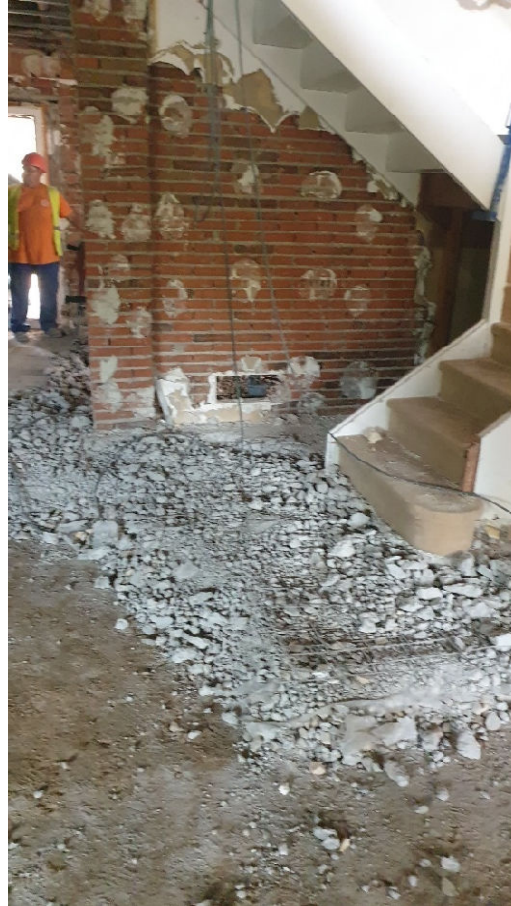
Foto 12. Terreno, solera y arranque de escalera
