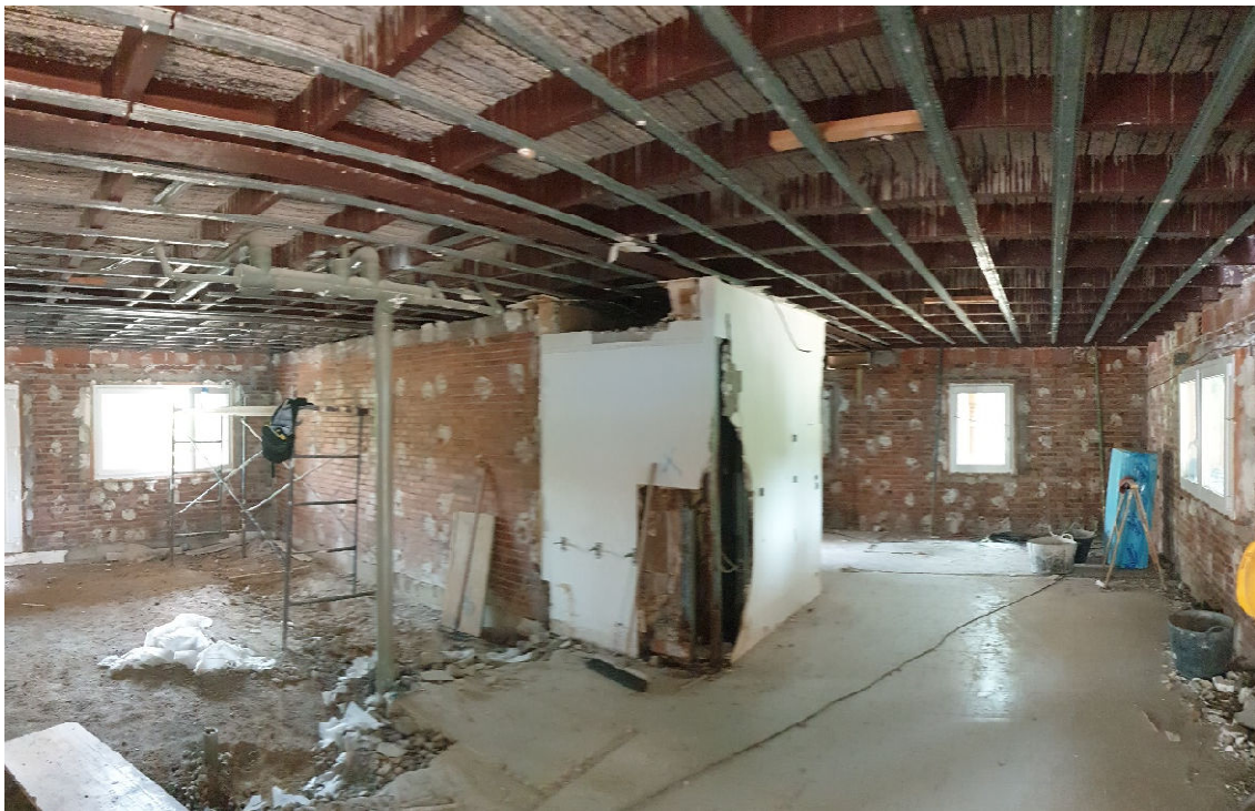
Foto 15. Vista desde el espacio de la cocina en Planta Baja
