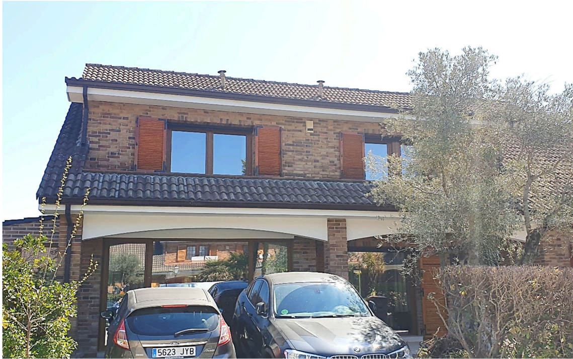
Foto 02. Vista exterior. Alzados noroeste.
