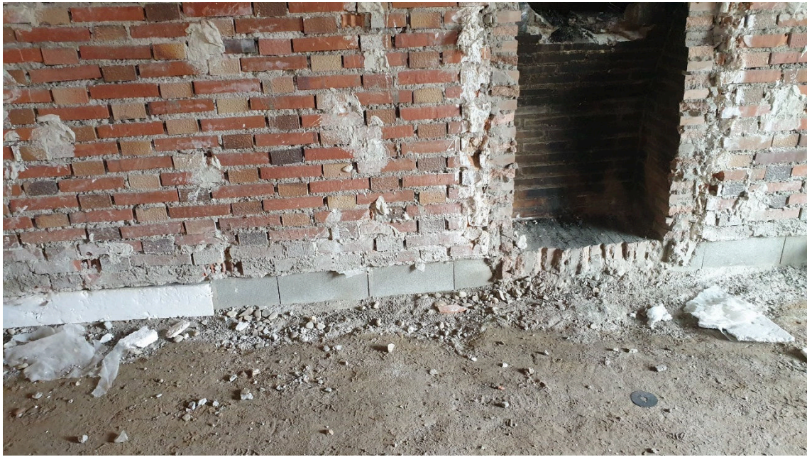
Foto 10. Arranque de muro perimetral de fachada
