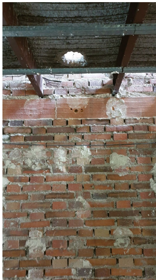
Foto 11. Huevo perimetral entre tablero de forjado y muro perimetral
