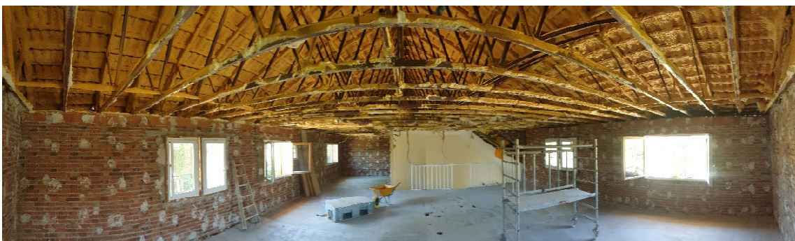
Foto 13. Cerchas de cubierta sobre planta 1
