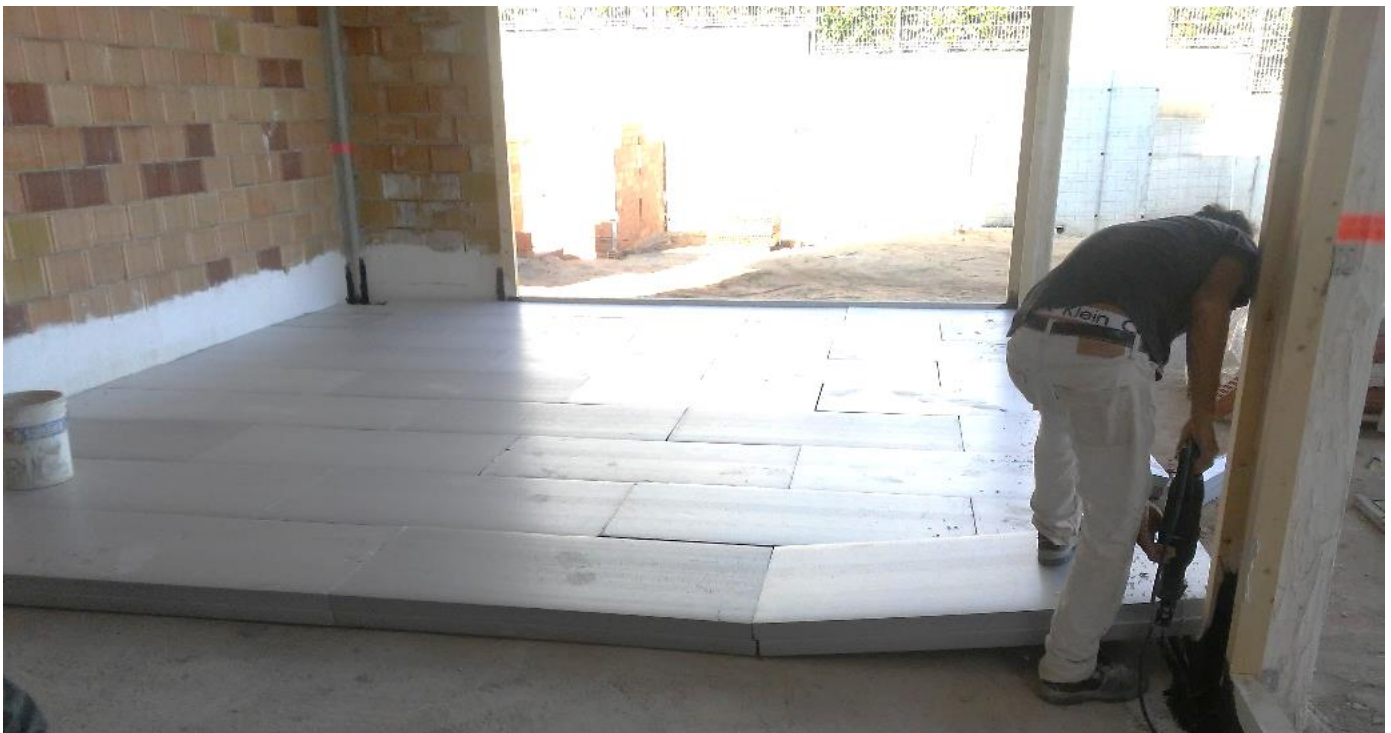
Aislamiento térmico de solera
