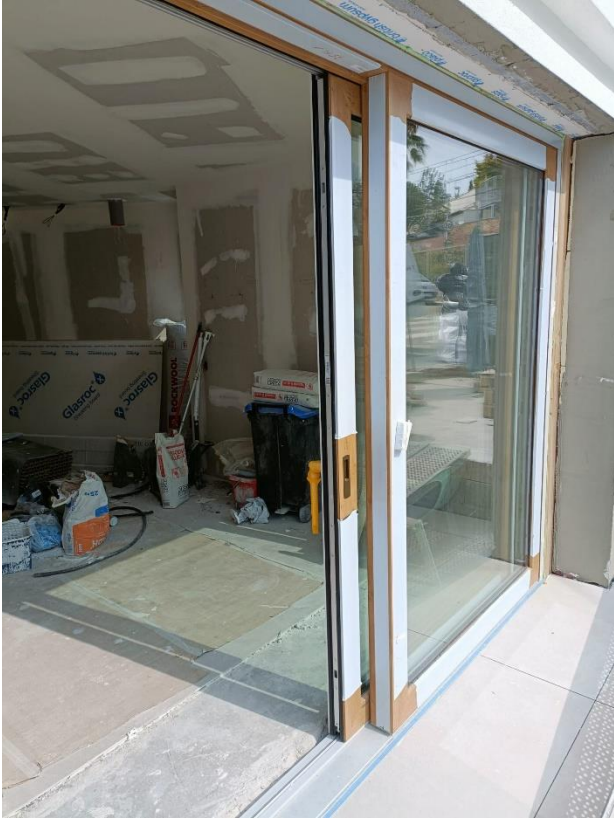
Colocación de ventanas
