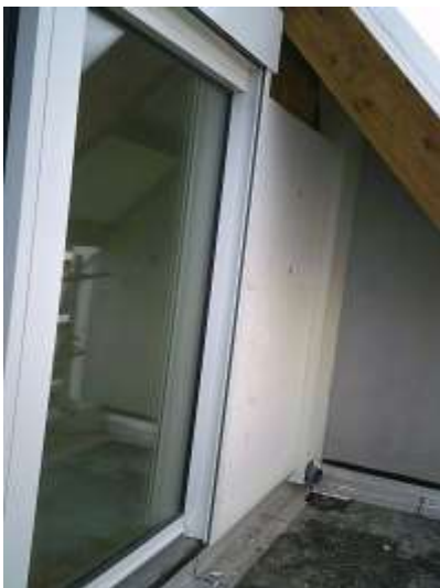
Isolation extérieure de mur ossature bois
