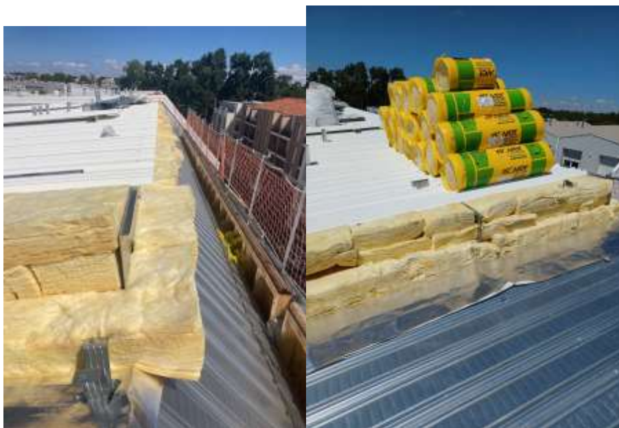
Mise en œuvre des 3 couches de laine de verre
