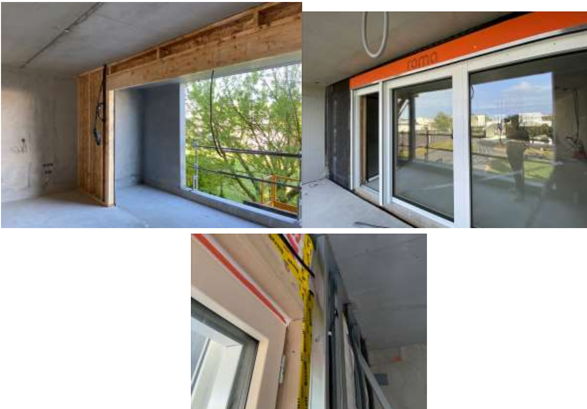
Photos de mise en œuvre
