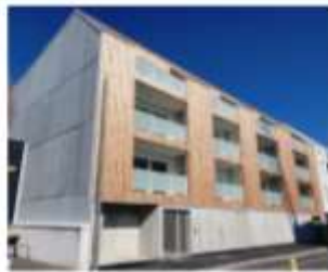
Bâtiment A – 12 Logements
