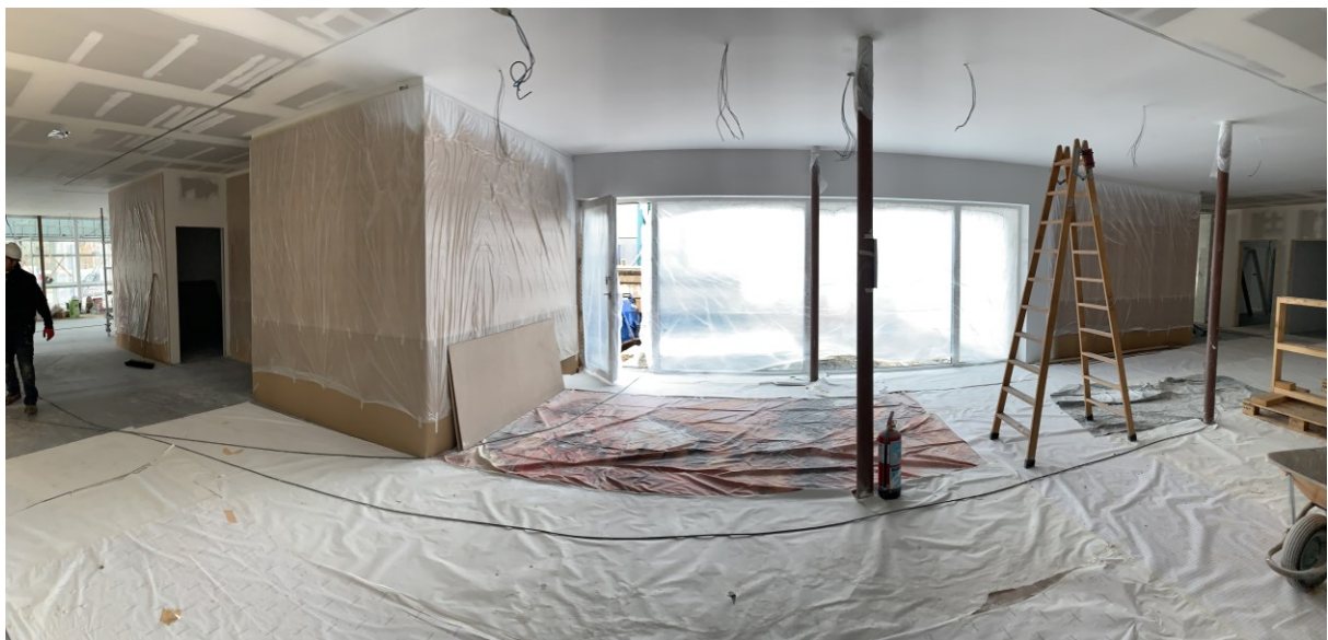
Fotografía de obra. Tabiquería de yeso laminado e instalaciones.
