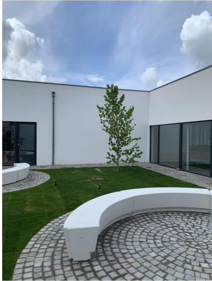
Fotografía de obra. Patio interior. Jardinería y mobiliario exterior.
