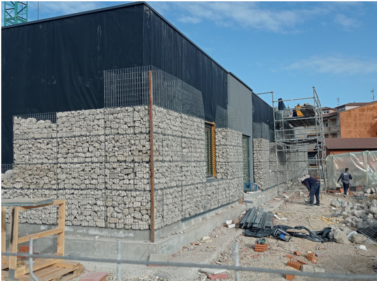
Fotografía de obra. Formación de gaviones en fachada.
