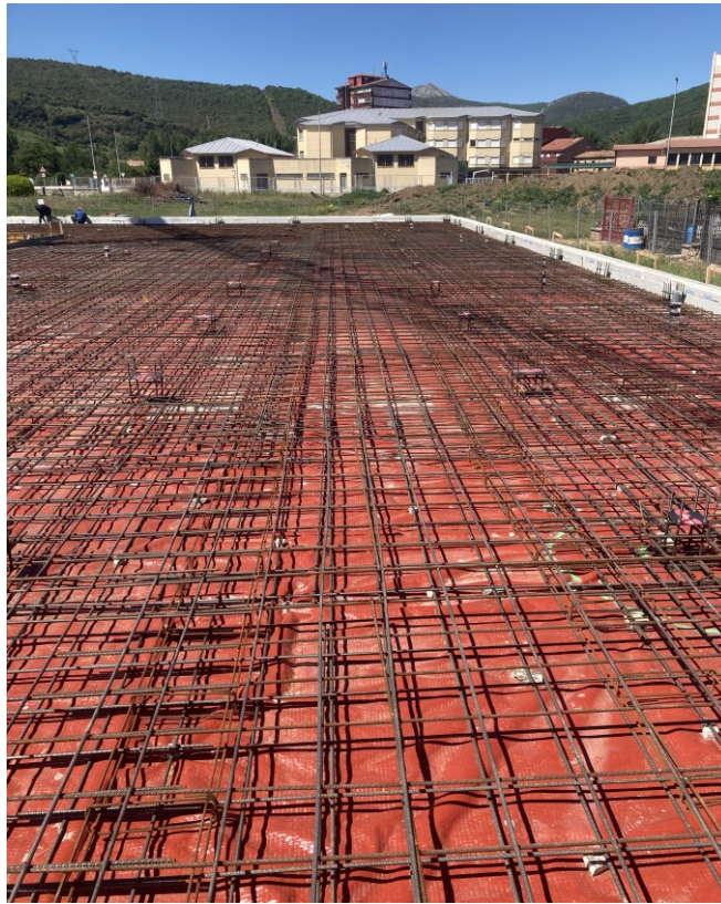
Fotografía de obra. Fase de cimentación.
