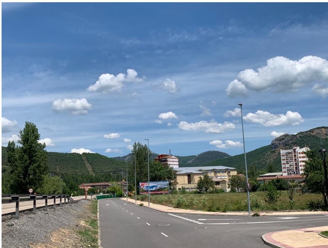
Solar vacante antes de la construcción del edificio. Carretera general al oeste.
