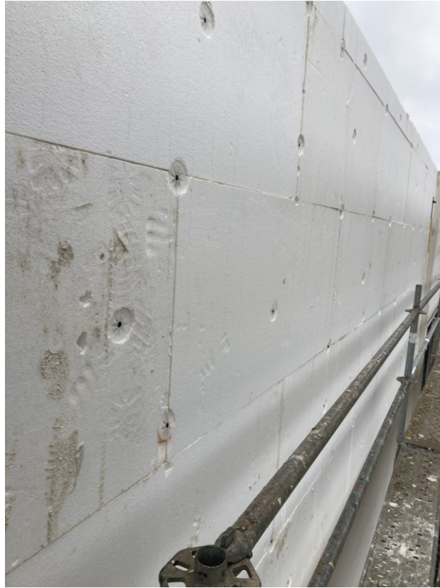
Fotografías de obra. Colocación de aislamientos en fachadas y cubierta.
