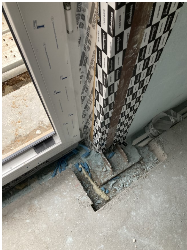
Fotografía de obra. Encintado de puntos singulares.
