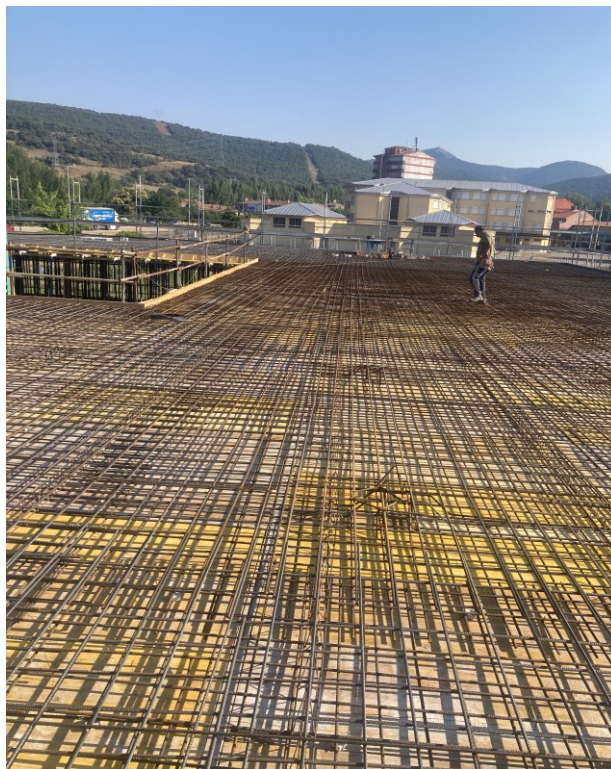
Fotografía de obra. Estructura de cubierta.
