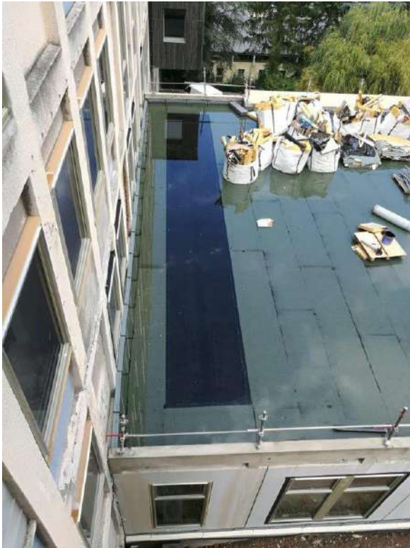
Réservations pour passer l'isolant de l'acrotère (détail H10)
