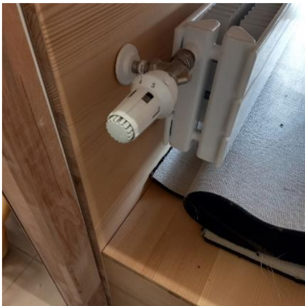
Figure 33: Tête thermostatique des radiateurs et corps de vanne de radiateur à débit régulé
