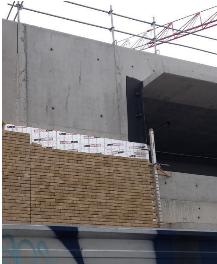
Figure 13: Isolation des murs extérieurs en cours de réalisation. Pose de l'isolant et des briques à l'avancement.
