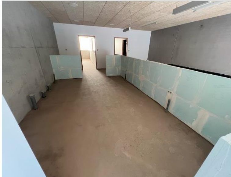
Figure 7 Salle des changes en cours de réalisation
