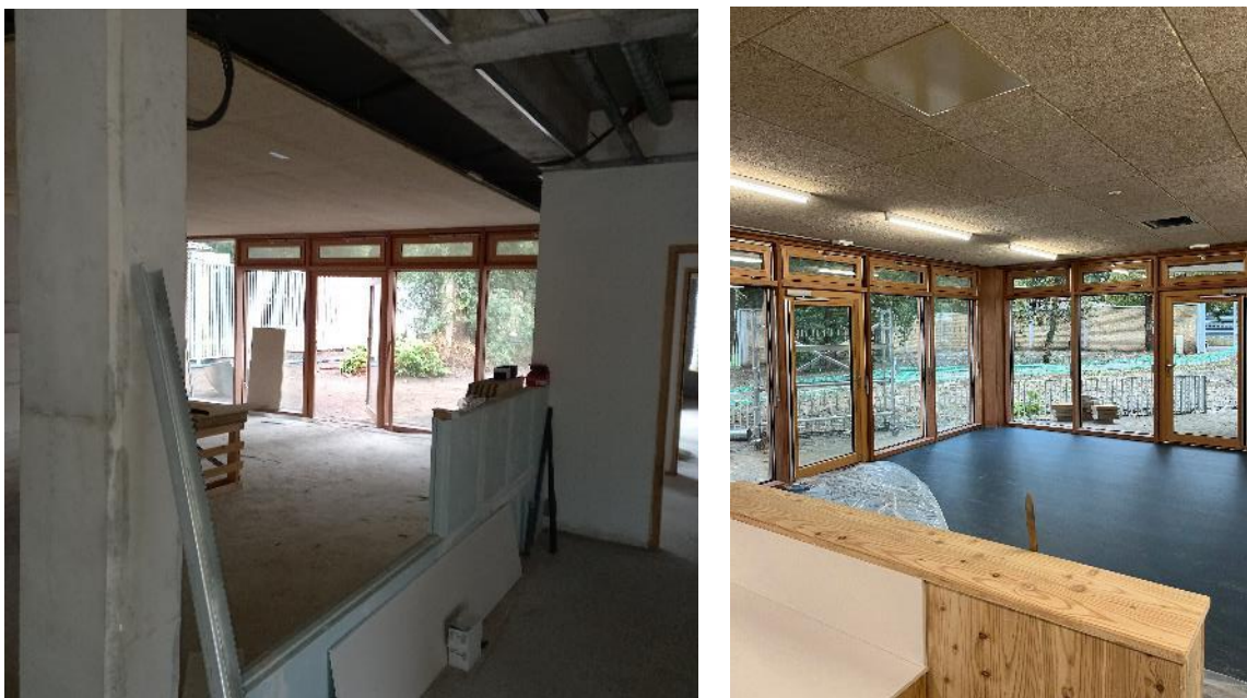
Figure 6: Hors d'eau, hors d'air – unité de vie des enfants au RDC, espace terminé à droite
