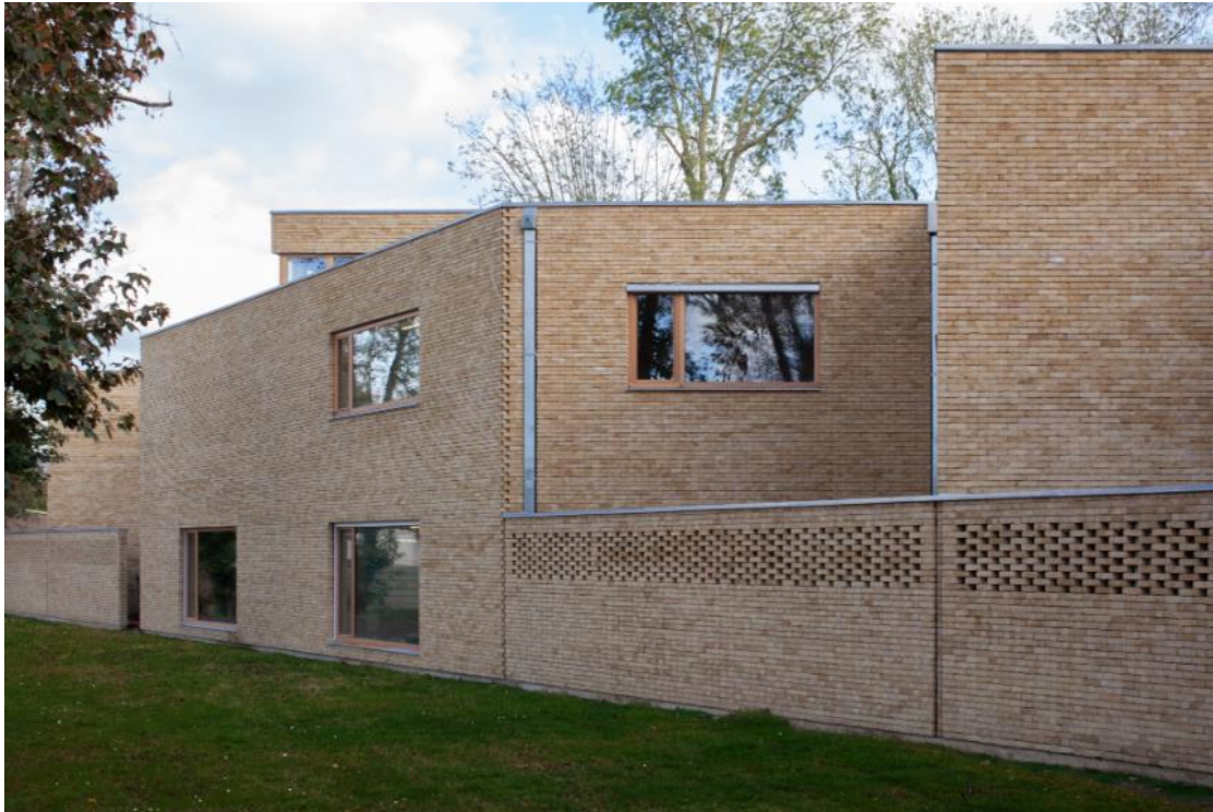
Figure 5: Vue d'ensemble de la façade côté nord - atelier HBAAT
