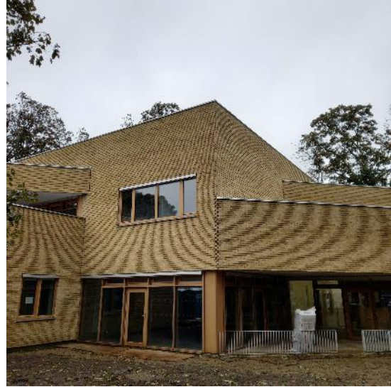
Figure 18: Ensemble menuisé triple vitrage permettant l'accès à la terrasse de l'étage à gauche, du RDC à droite
