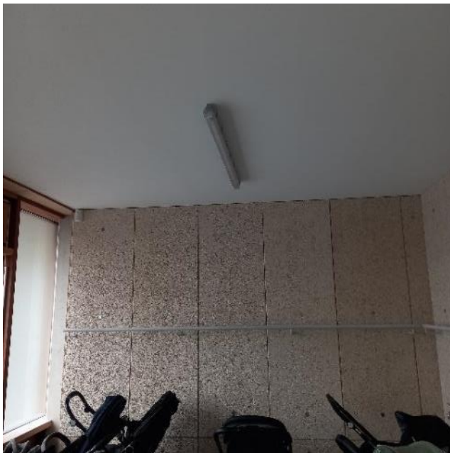
Figure 14: Isolation des murs sur locaux non chauffés
