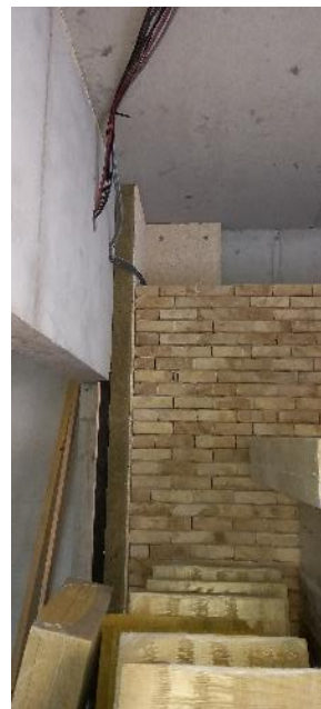
Figure 14: Isolation des murs sur locaux non chauffés
