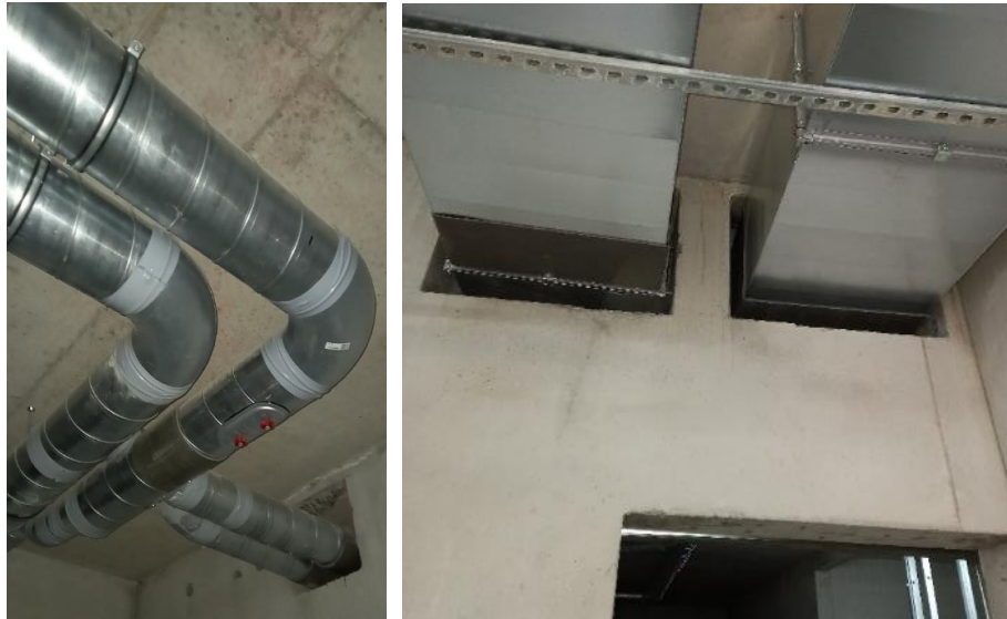
Figure 25: réseau de ventilation en cours de pose montrant les trappes de visite
