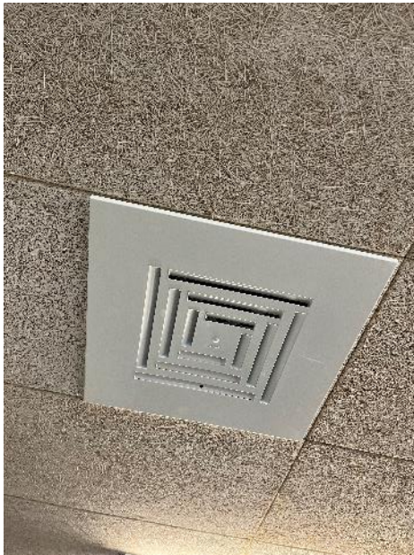
Figure 23: Bouche de soufflage et module de régulation
