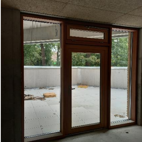
Figure 18: Ensemble menuisé triple vitrage permettant l'accès à la terrasse de l'étage à gauche, du RDC à droite
