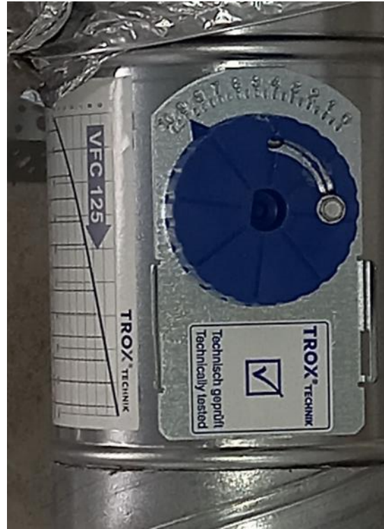
Figure 23: Bouche de soufflage et module de régulation
