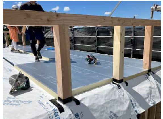
気密シート&屋根断熱 Q1ボード t61 \lambda 0.021
