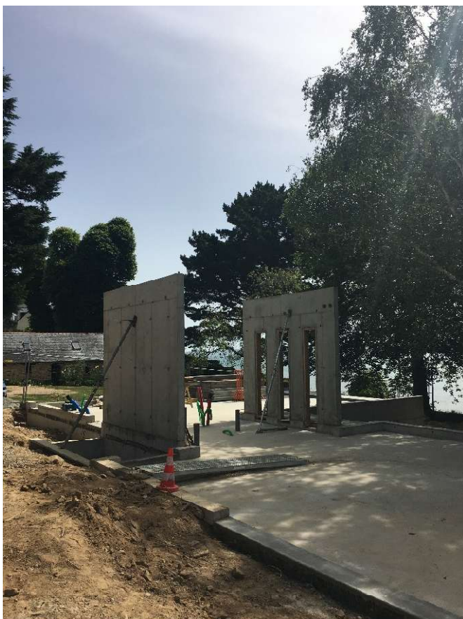
22 : Construction des parois béton sur la base du plancher coulé, avant les ossatures bois sur le reste de la construction.
