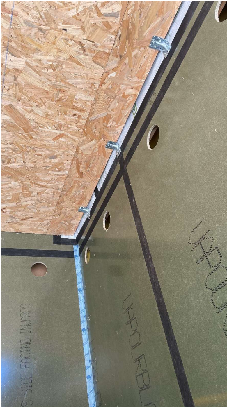
31 : Exemple de bonne mise en œuvre pour de l'étanchéité
