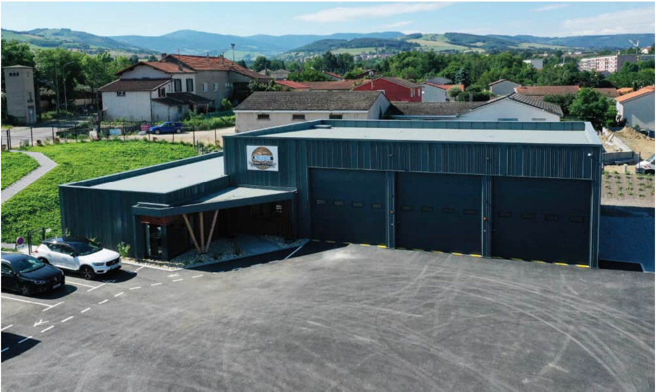
Façade Nord et Ouest
