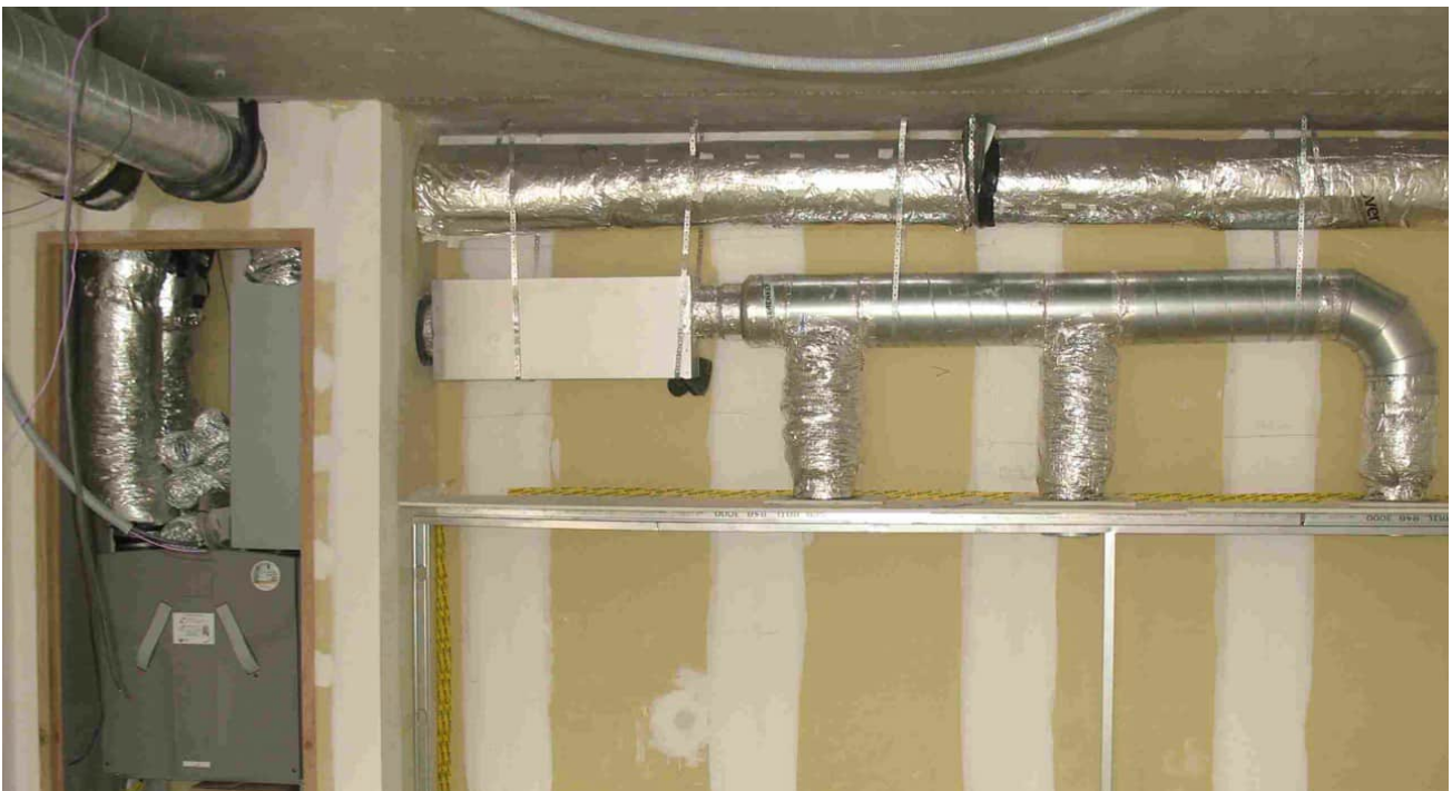
Mise en œuvre de la CTA de la salle de réunion
