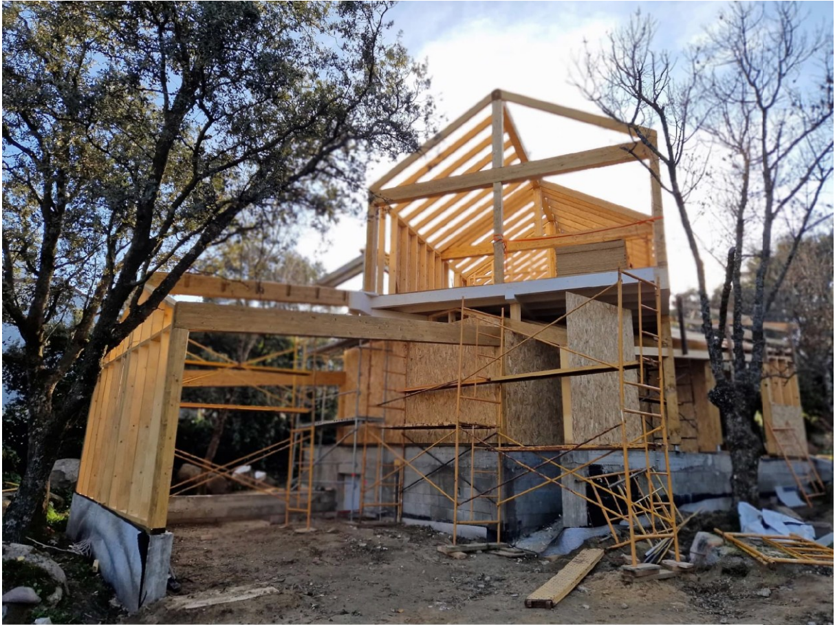
Estructura de madera
