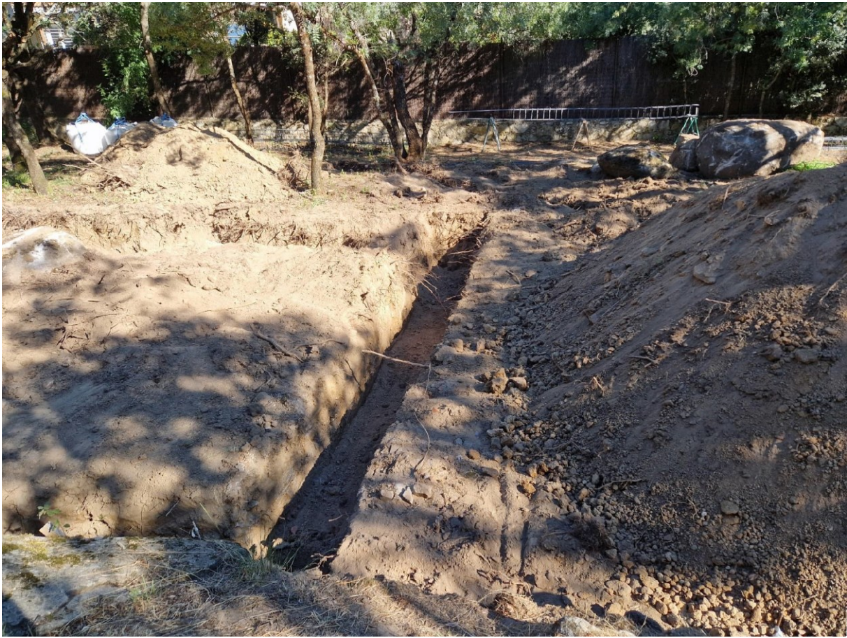
Preparado del terreno
