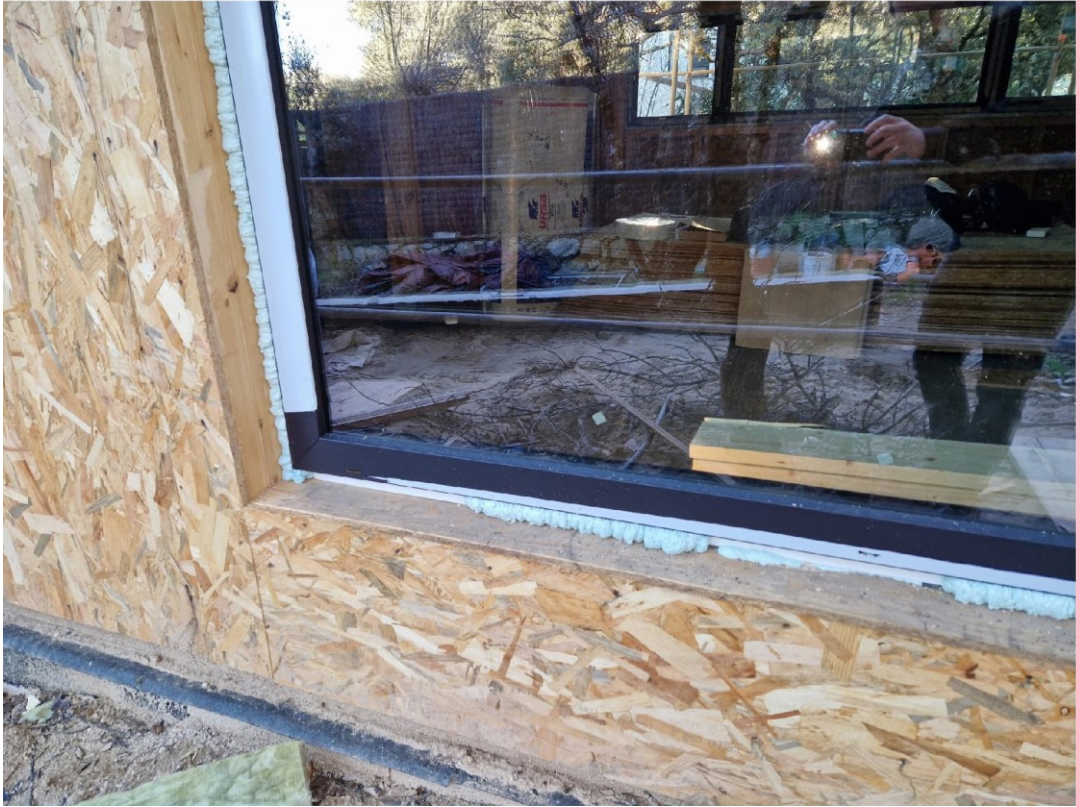
Sellado de ventanas
