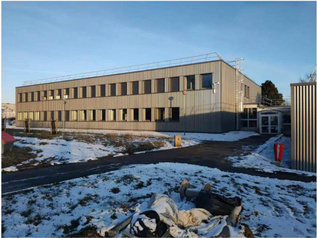
Façade Sud et Est
