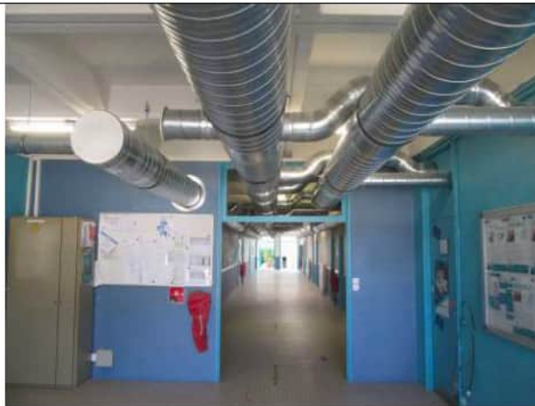
Gaines dans la circulation du RdC
