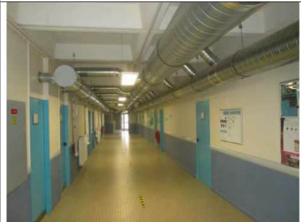
Gaines dans la circulation du RdC
