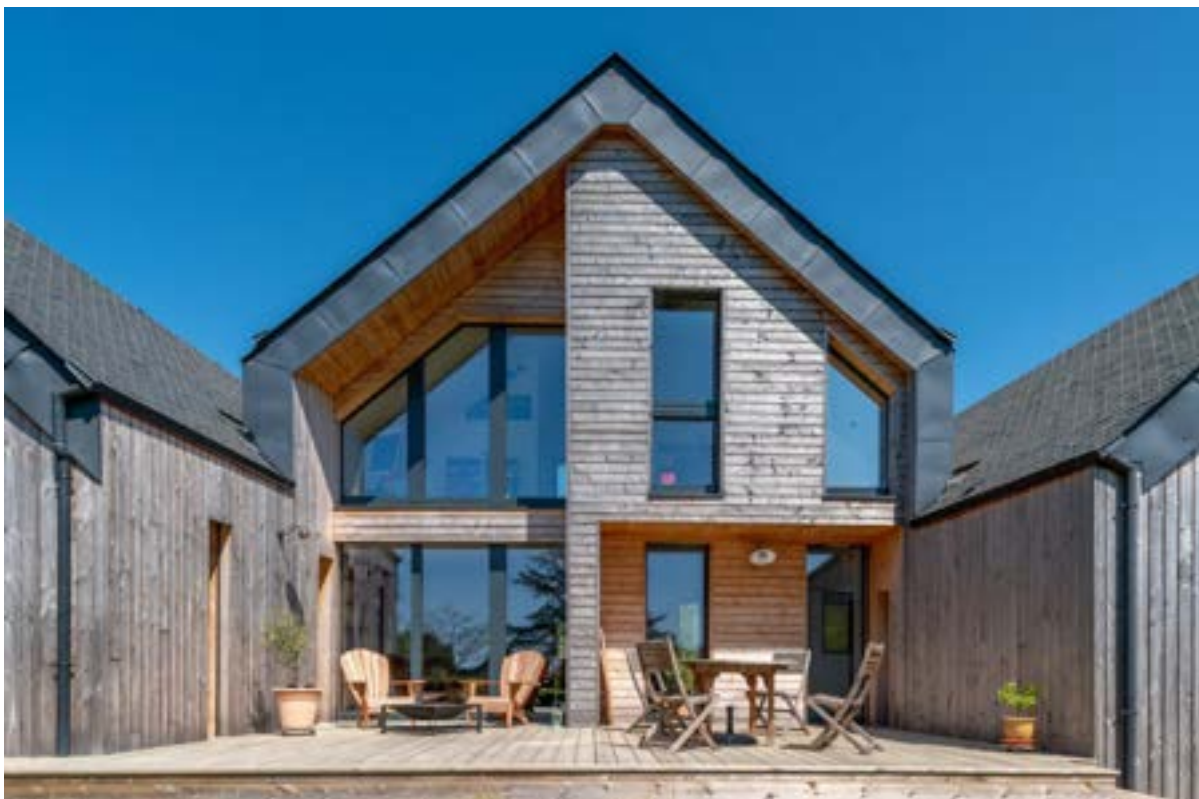
2 : Façade Sud / vue de face
