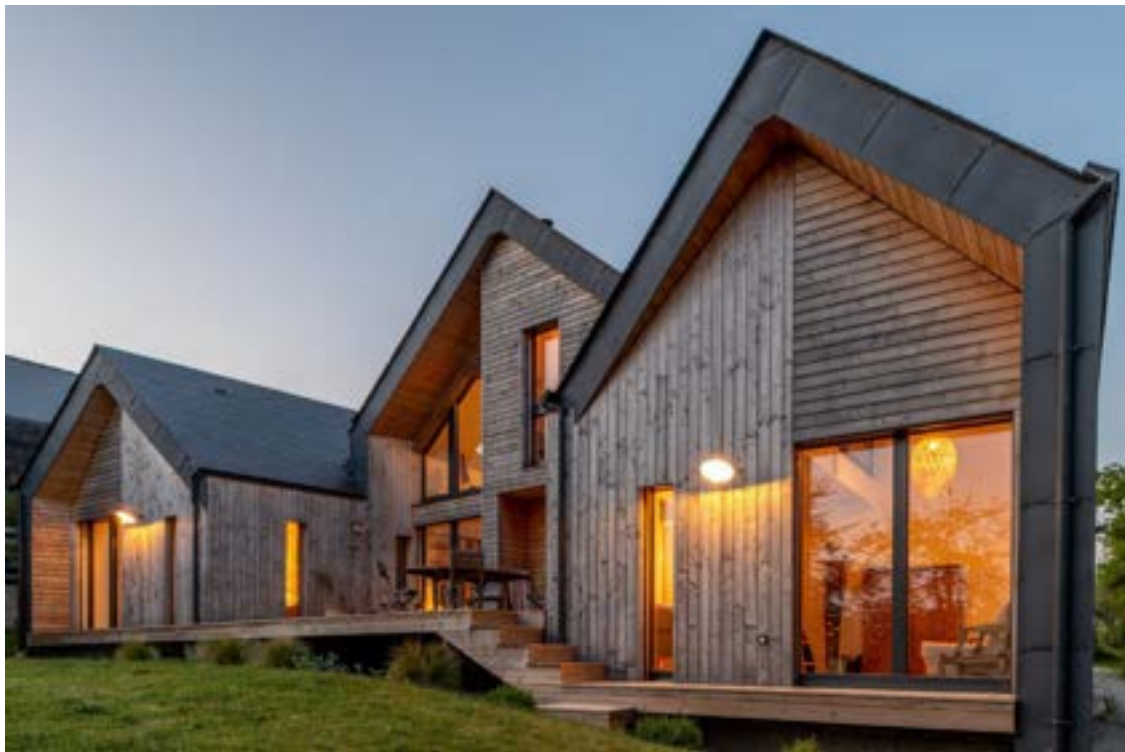
1 : Façade Sud / Angle Est
