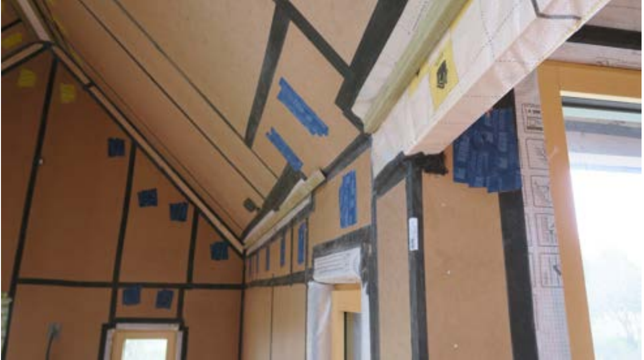
24 : Mise en œuvre de l'étanchéité à l'air dans la maison.
