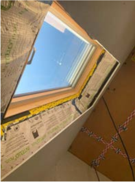
29 : Étanchéité à l'air autour d'un velux.
