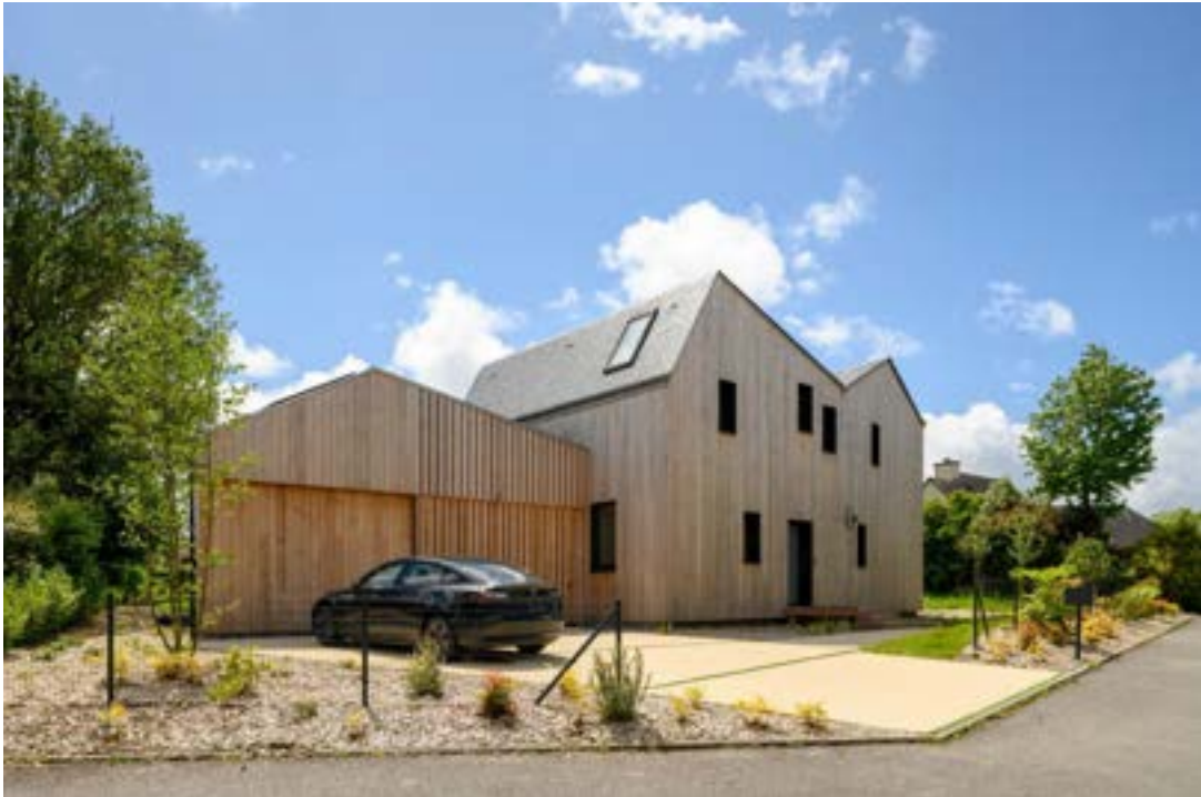
2 : Façade Nord-Est / Angle Est
