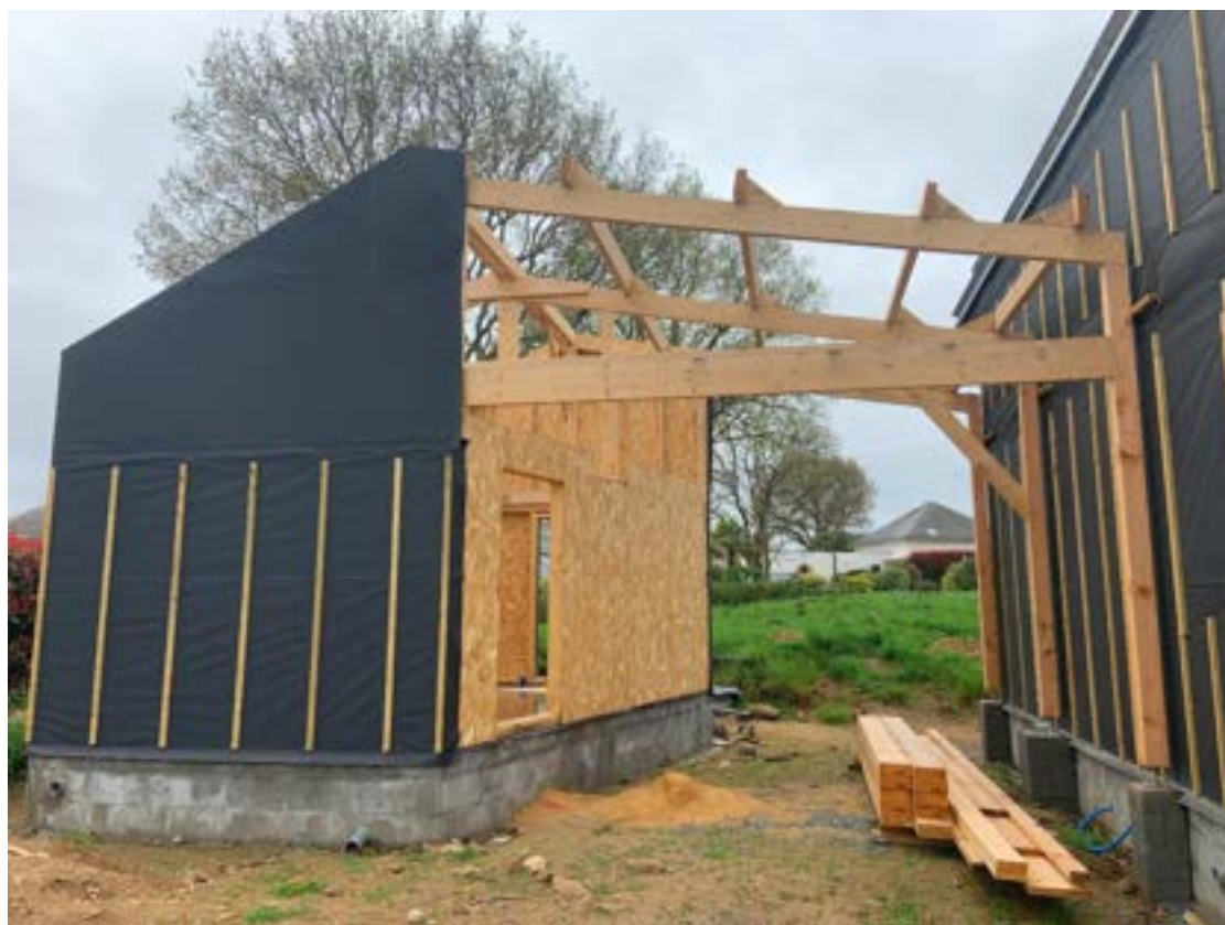
19 : Mise en œuvre des murs MOB sur les socles béton. Ci-contre : volume non chauffé au contact du garage.
