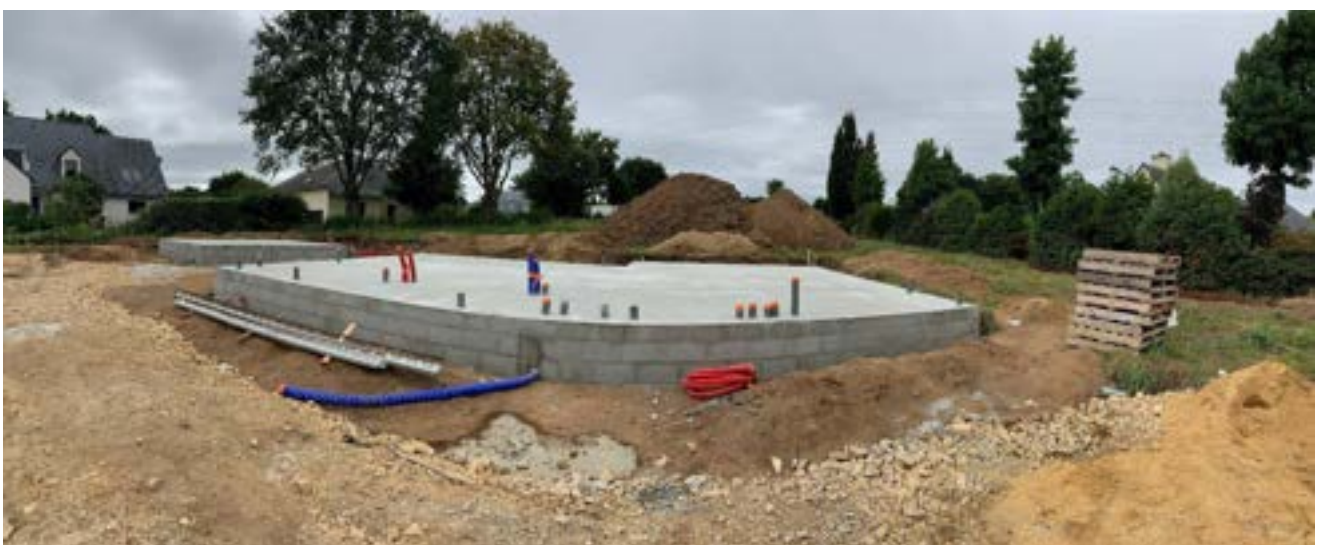
17 : Photographie de la dalle portée coulée sur les fondations, en début de chantier
