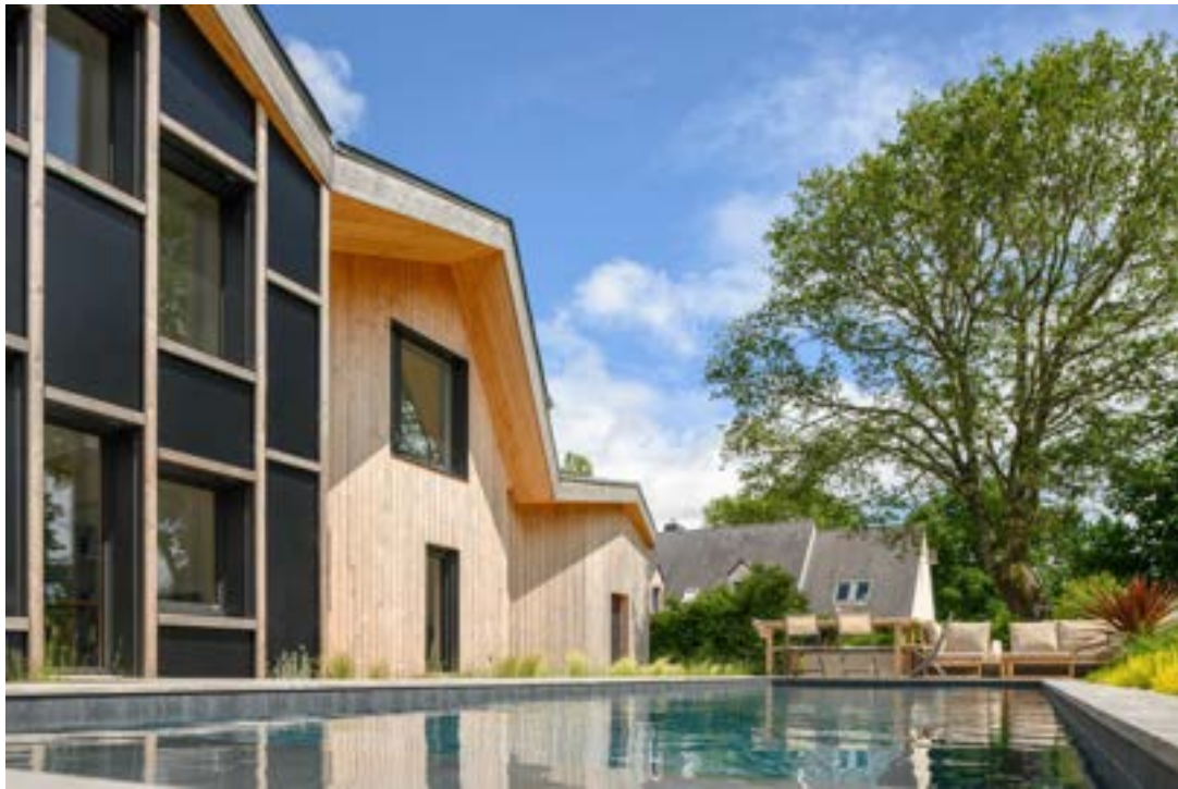
1 : Façade Sud-Ouest / Angle Ouest
