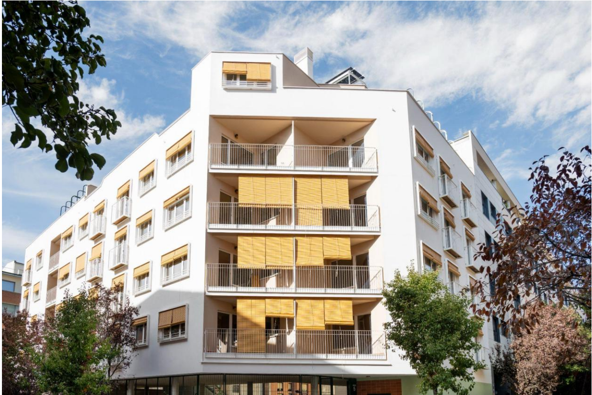
Chaplán entre fachada sureste y noreste. En este paño están las terrazas orientadas a Este. Están protegidas con persianas enrollables de madera como las ventanas.
