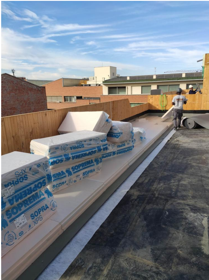
C.02 Cubierta plana transitable U = 0,134 W/(m²K)
