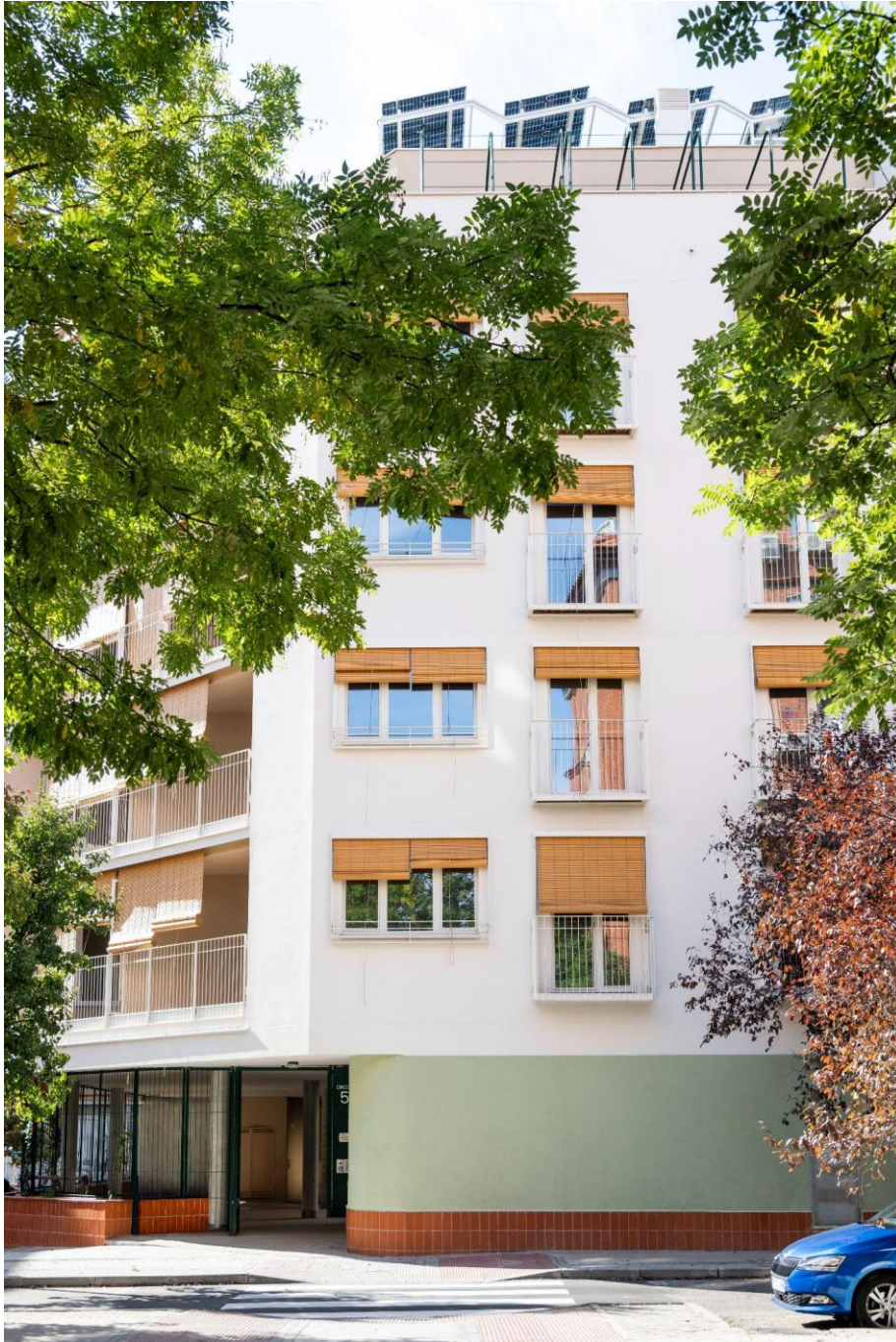
Fachada noreste. Se aprecia en la parte superior parte de los paneles fotovoltaicos instalados. También estas ventanas están protegidas con persianas enrollables
