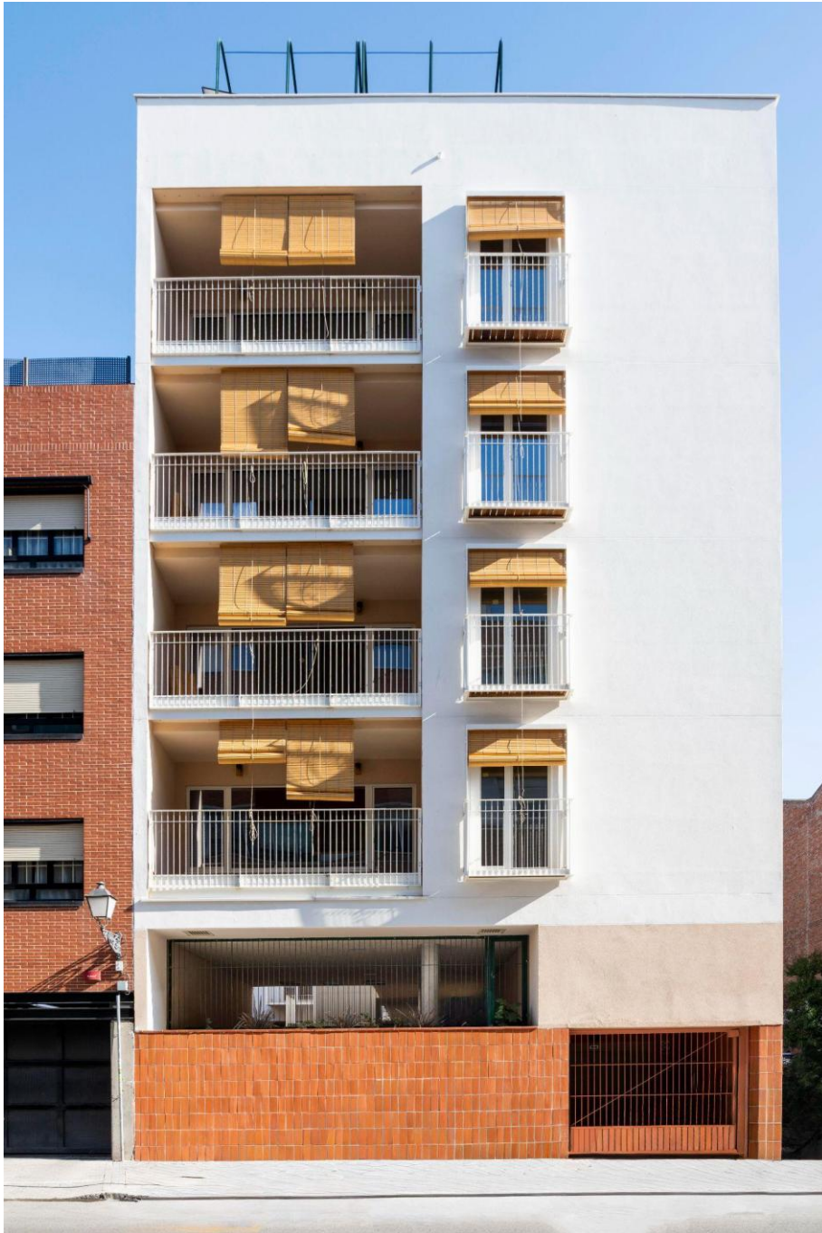
Fachada suroeste. Terrazas conectadas con los salones con ventanas de gran tamaño y con protección solar al exterior.
