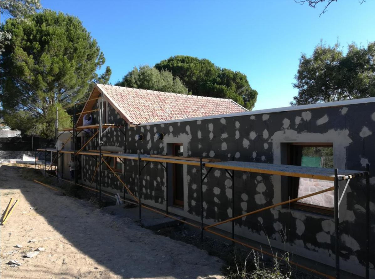
COLOCACIÓN DEL SISTEMA DE AISLAMIENTO TÉRMICO POR EL EXTERIOR
