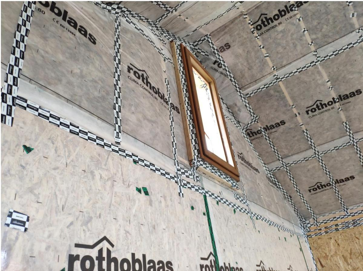
LÁMINAS DE ESTANQUEIDAD INTERIOR Y ESTANQUEIDAD DE LA ESTRUCTURA DE CUBIERTA
