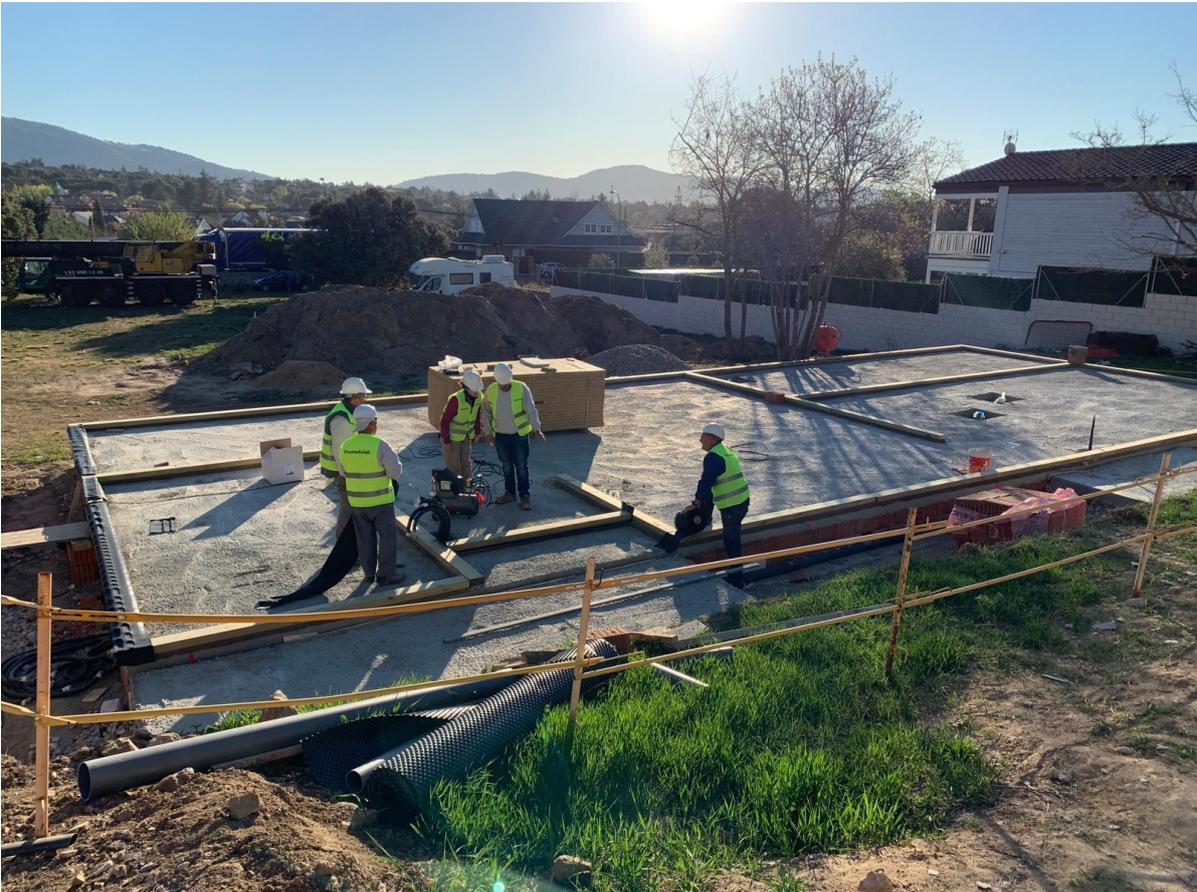
COLOCACIÓN DE DURMIENTE PARA EL APOYO DEL ENTRAMADO LIGERO DE MADERA
