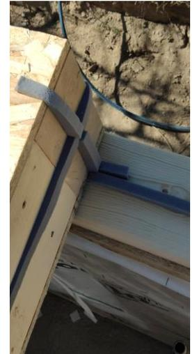
Se ha tenido especial cuidado en las uniones en seco de los componentes de la estructura de manera que no se creen puentes de aire entre los elementos que nos pudieran generar puentes térmicos en la envolvente.
