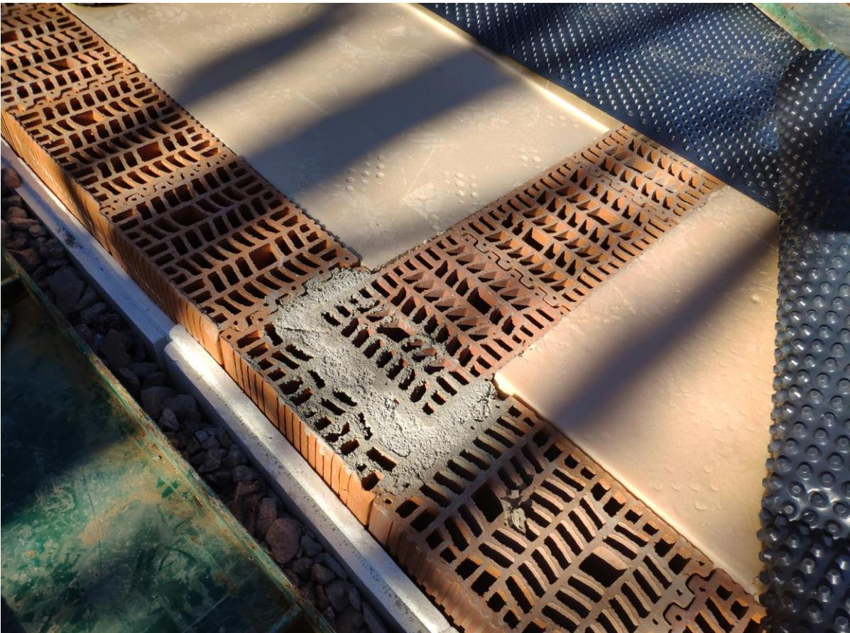
AISLAMIENTO DEL MURO DE CIMENTACIÓN, AISLAMIENTO Y DRENAJE DE SOLERA
