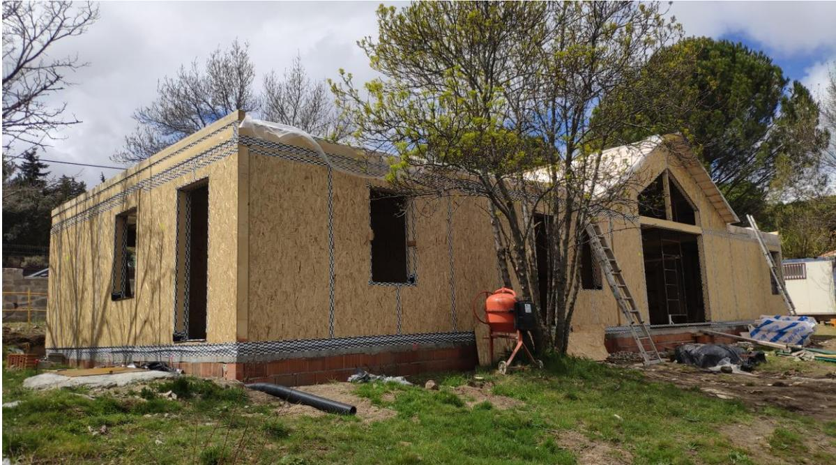
SELLADO DE PANELES Y TABLERO POR EL EXTERIOR DE LA ESTRUCTURA DE ENVOLVENTE.
