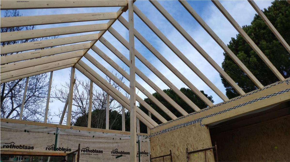
CUBIERTA DE ENTRAMADO LIGERO DE MADERA COMPUESTA POR PARES E HILERA
