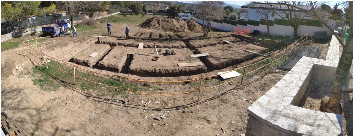
EXCAVACIÓN PARA LA CIMENTACIÓN MEDIANTE ZAPATAS CORRIDAS DE LA VIVIENDA
