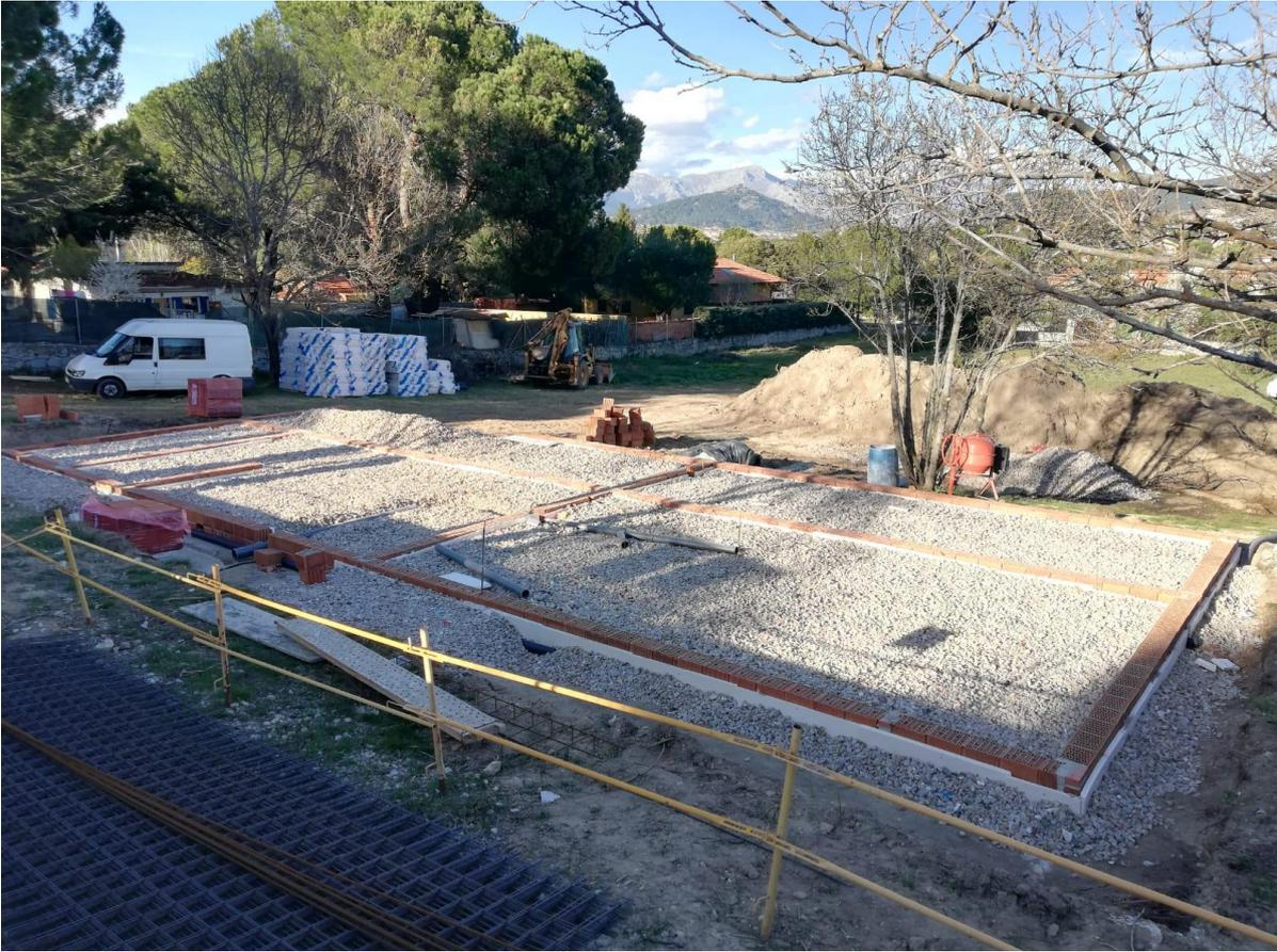
CAPA DE GRAVA VENTILADA Y DRENADA PARA EL APOYO Y DRENAJE DE LA SOLERA
