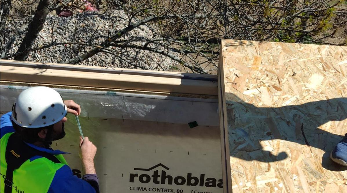
DETALLE DE ELEMENTOS DE SELLADO DE JUNTA SECA ENTRE PANELES PREFABRICADOS DE ENTRAMADO LIGERO DE MADERA
