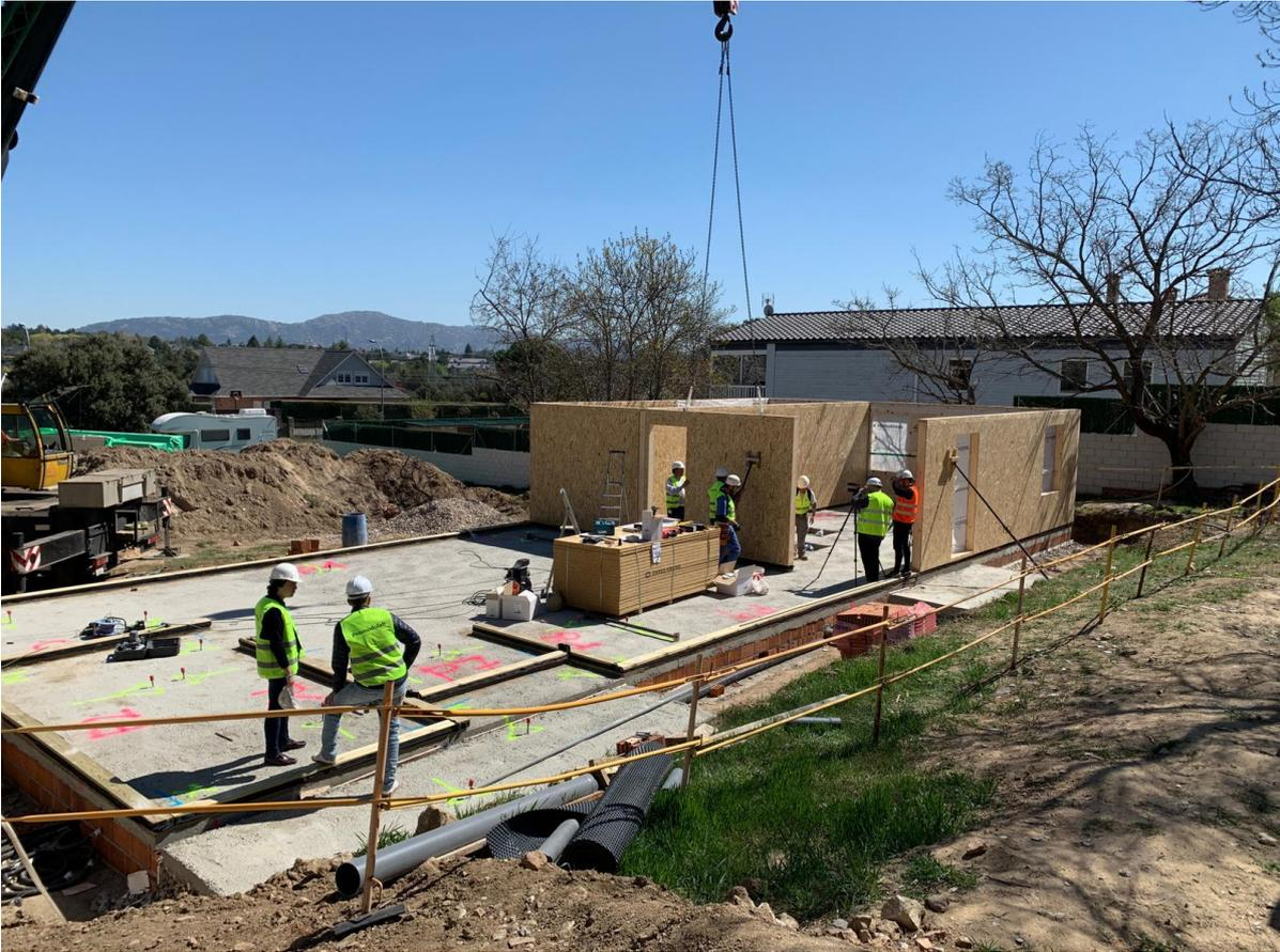
SECUENCIA DE MONTAJE DE LOS PANELES PREFABRICADOS DE ENTRAMADO LIGERO DE MADERA
