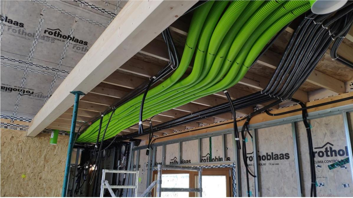
SISTEMA DE CONDUCTOS DE RENOVACIÓN DEL AIRE CON RECUPERADOR DE CALOR
