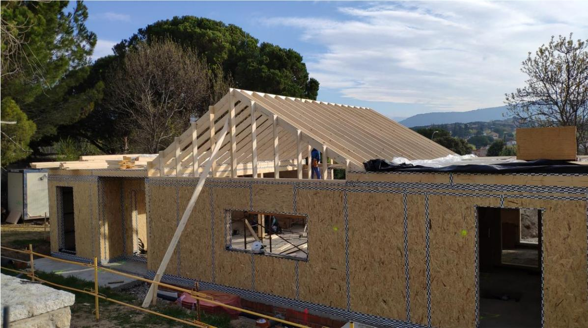
CUBIERTA DE PAR E HILERA Y DETALLE DE HASTIAL DE ENTRAMADO LIGERO DE MADERA
