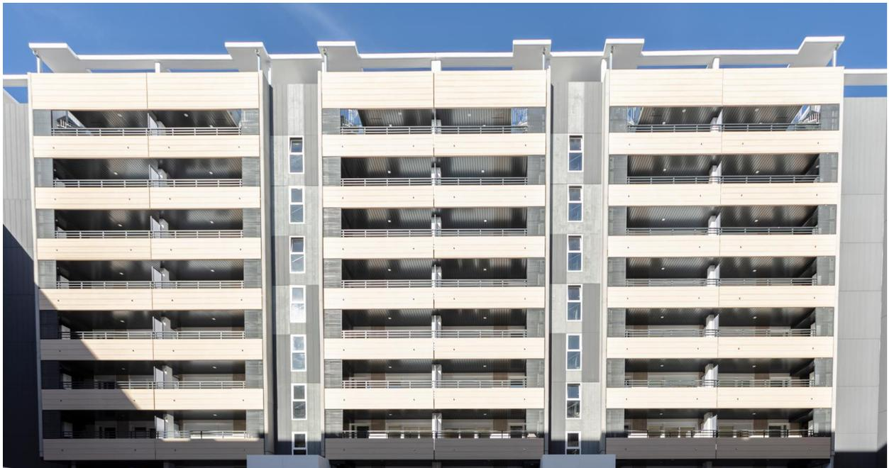
*Vista del alzado interior este, con terrazas y fijos mini onda que proporcionan protección solar a fachadas de salón y cocinas
