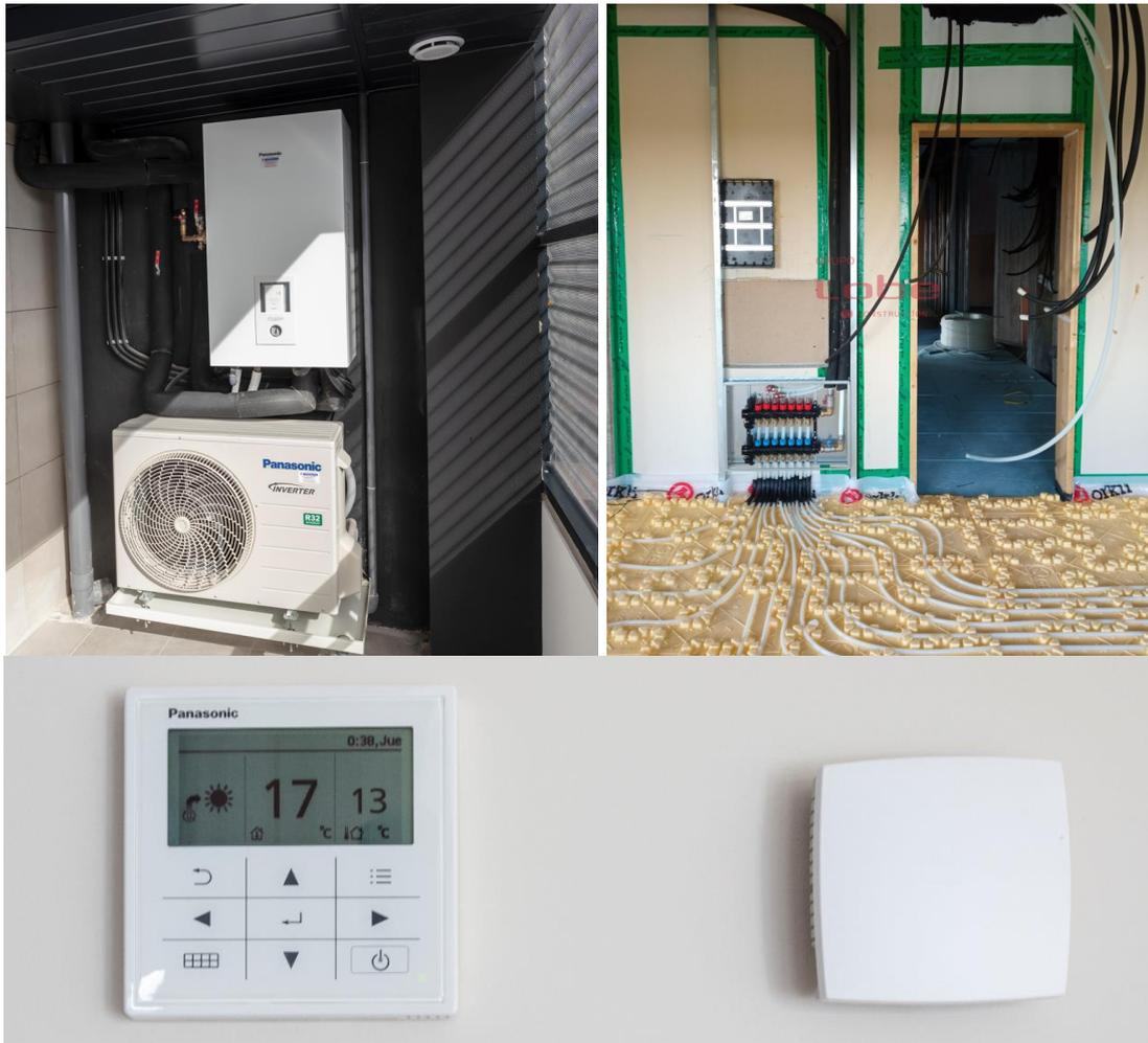
Sistema individual de climatización. Aerotermia aire- agua + suelo radiante refrescante. Fuente: Grupo Lobe
