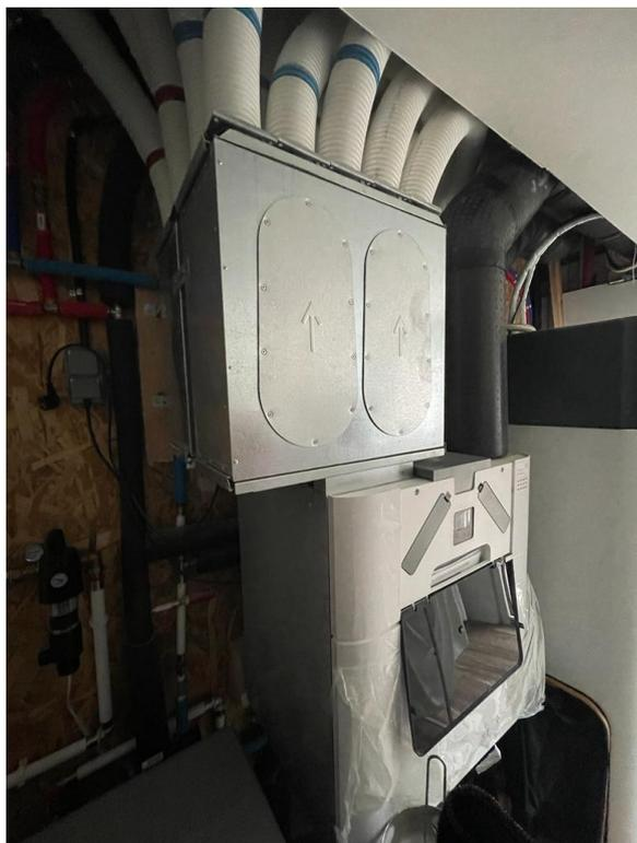
Se utilizó un sistema ventilación mecánica de doble flujo con intercambiador de calor, para reducir la demanda de calefacción y refrigeración, y garantizar una buena calidad del aire.
