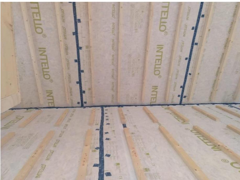
Cintas adhesiva hermética al aire Tescon Vana para unión entre láminas reguladoras de vapor y hermeticidad al aire, y para unión entre como entre tableros de madera.
