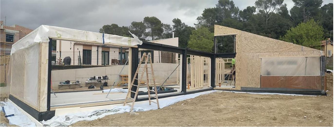
*Montaje de la estructura principal del entramado – Fachada Sur-Oeste (Jardín)*
