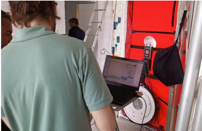
Se realizó una primera prueba de hermeticidad en la fase intermedia de obra, con todas las instalaciones pasadas y los trasdosados interiores abiertos para tener acceso a la capa hermética para detectar y reparar posibles infiltraciones.
