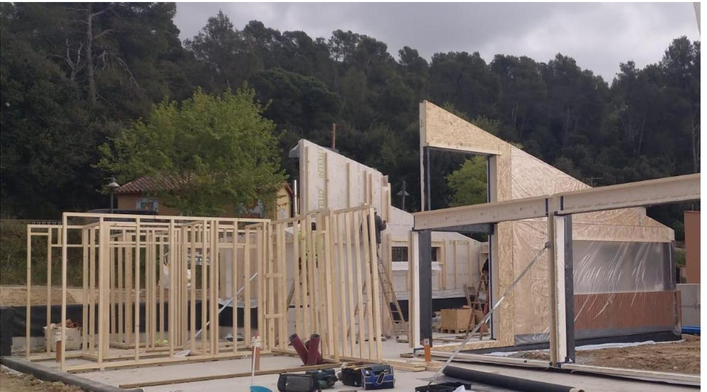
*Montaje de la estructura principal del entramado – Fachada Norte*
