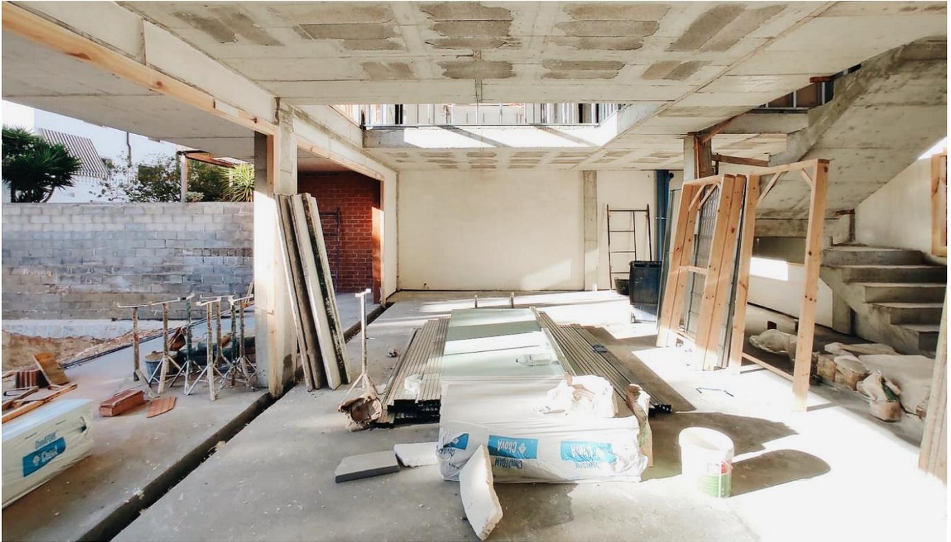
Estructura de hormigón con cerramientos de termoarcilla enyesados
