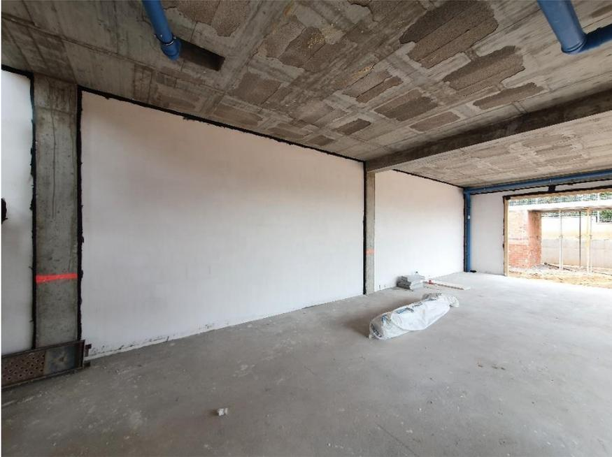
Detalle de la solución de la hermeticidad en muros y pilares con la pintura Soudatight LQ y la capa interior de enyesado a la termoarcilla.
