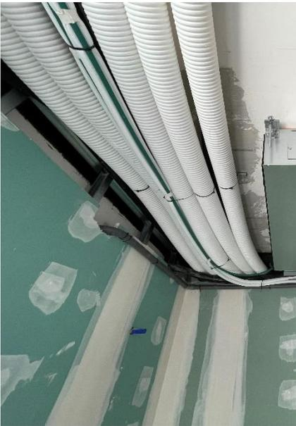
Distribución de conductos de ventilación por techo en sala
