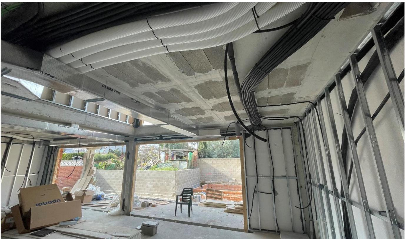
Montaje de la estructura principal del pladur – Instalaciones
