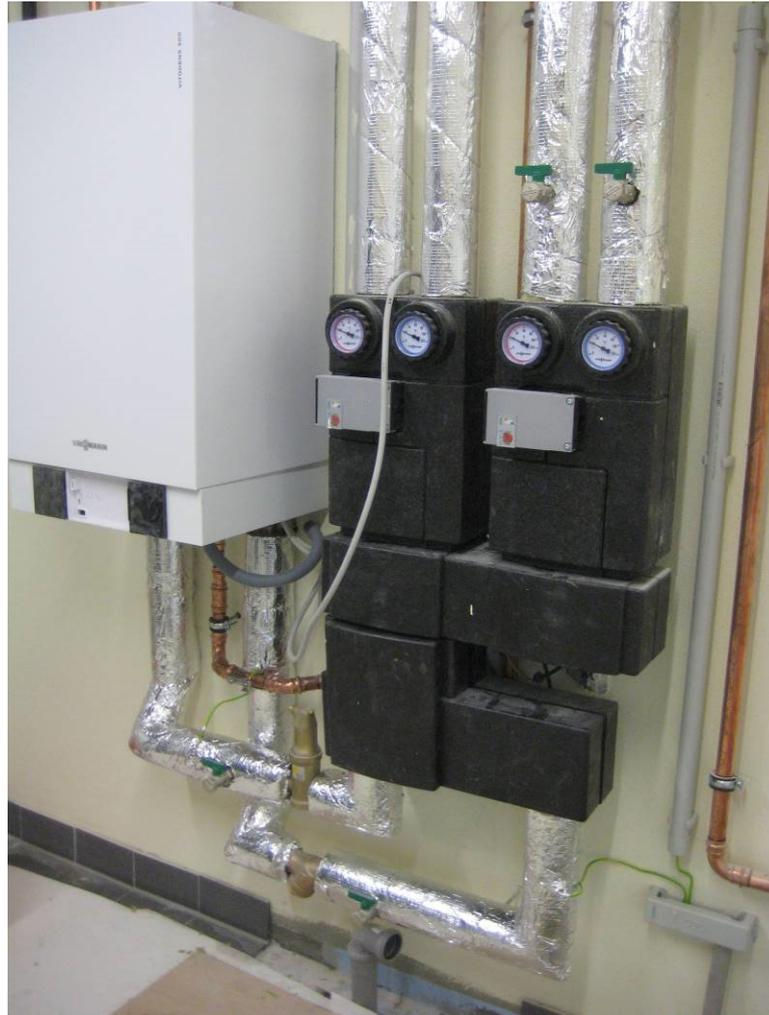
Abb. 24 Heizkessel Viessmann Vitodens 300
