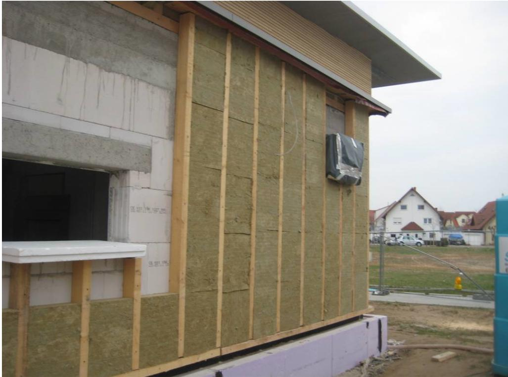
**Abb. 10 Dämmung der Außenwände, erste Dämmlage mit Holzständerkonstruktion**
