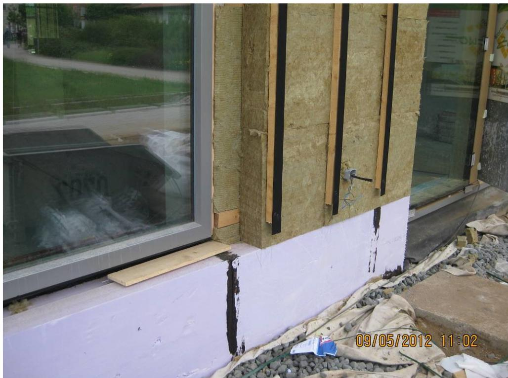
**Abb. 19** Luftdichter Einbau der Fenster
