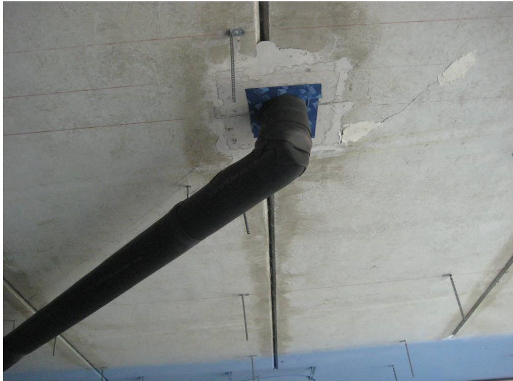
Abb. 17 Luftdichte Abdichtung einer Durchdringung der Betondecke
