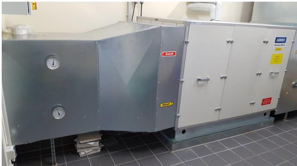
Abb. 22 Lüftungsgerät Aerex Reco Box 2000 ZX
