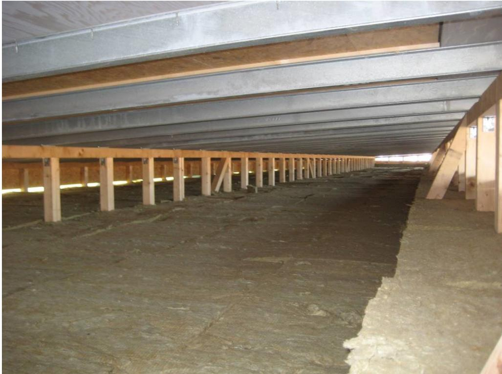
Abb. 12 Dämmung des Pultdachbereiches der beiden seitlichen Gebäudeteile
