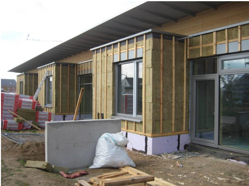
**Abb. 11 Dämmung der Außenwände, zweite Dämmlage vor Anbringen der Verkleidungsplatten**
