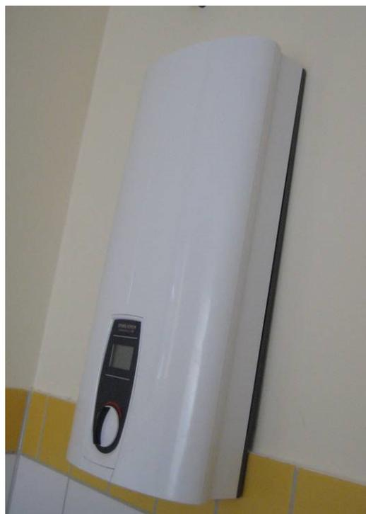
Abb. 26 Elektrischer Durchlauferhitzer
