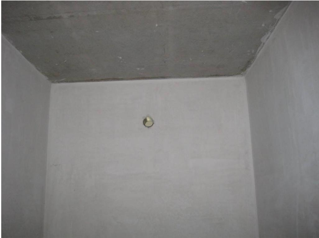
**Abb. 18** Sicherstellung der Luftdichtheit durch vollflächigen Putzauftrag, der bis an die Rohdecke herangeführt wurde
