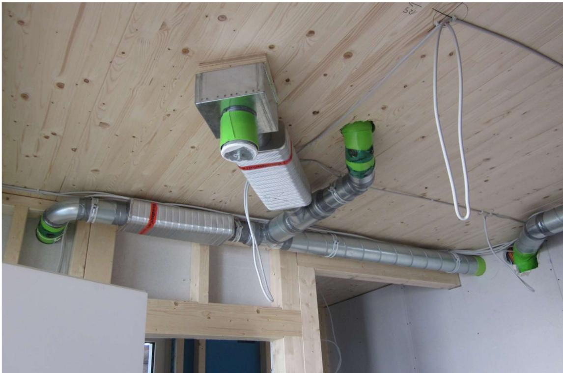
**Kanalführung mit Schalldämpfer und Luftauslass im EG (abgeh. Decke folgt)**
