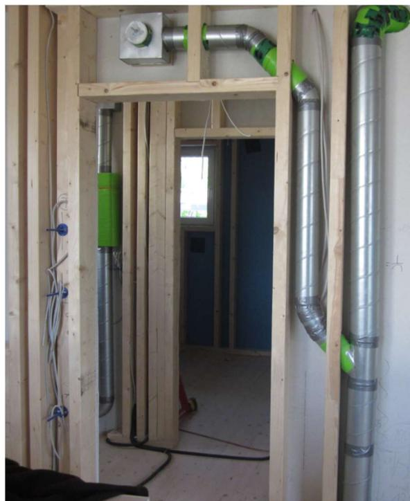
**Lüftungsleitungen/Steigleitungen in den Innenwänden**
