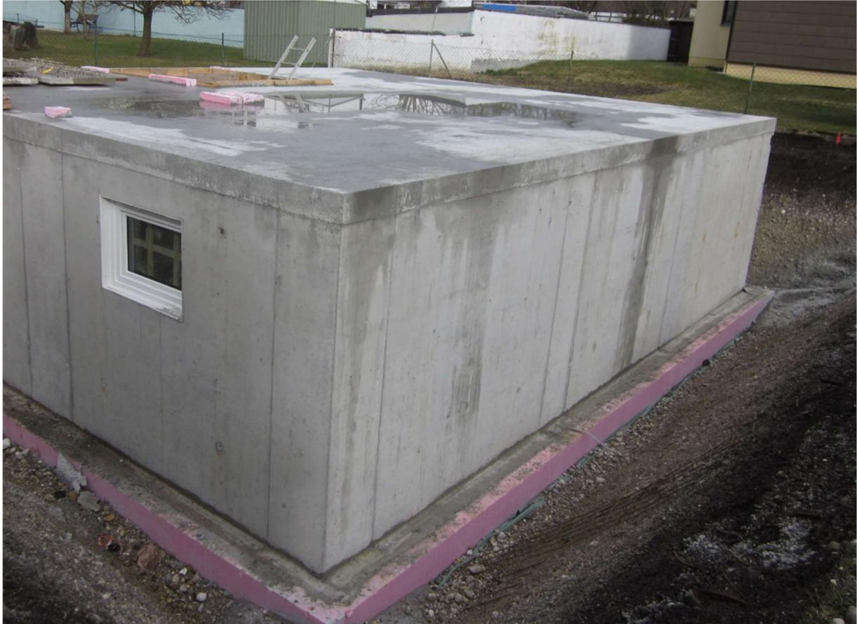
**Keller Rohbau – Überstand Bodenplatte mit Dämmung**
