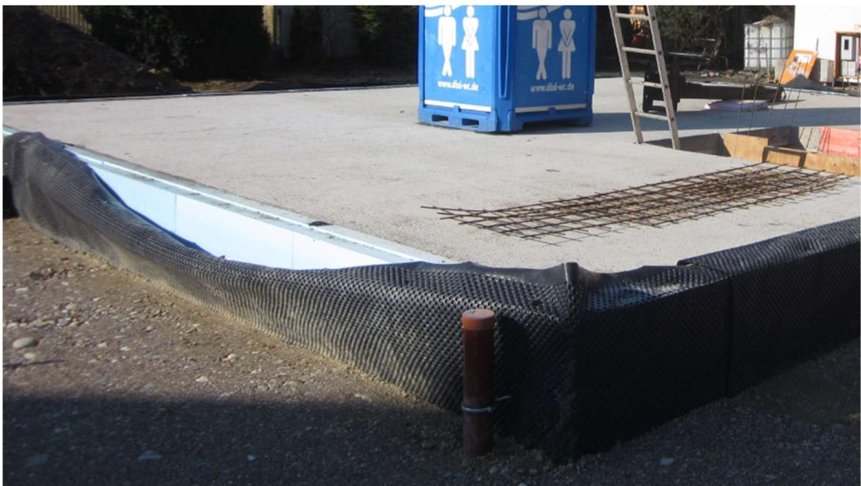
**Kelleraußenwand mit 2-lagiger Dämmung und Noppenbahn**
