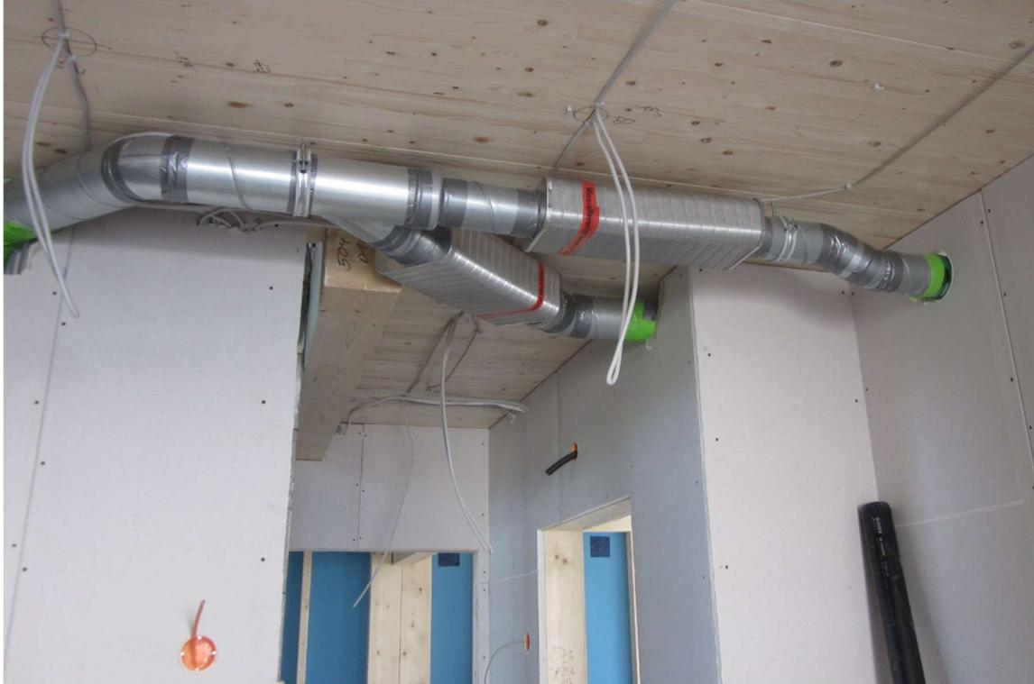
**Kanalführung mit Schalldämpfer im OG (abgeh. Decke folgt)**
