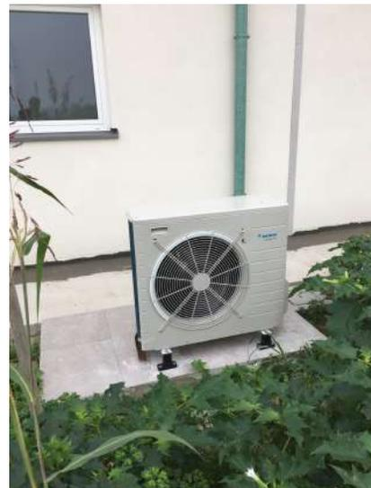
L'acqua calda sanitaria è prodotta dalla pompa di calore splittata che alimenta il suo accumulo interno di 300 lt.
