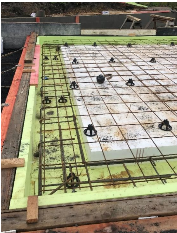
Photo : Concrete Slab Edge
