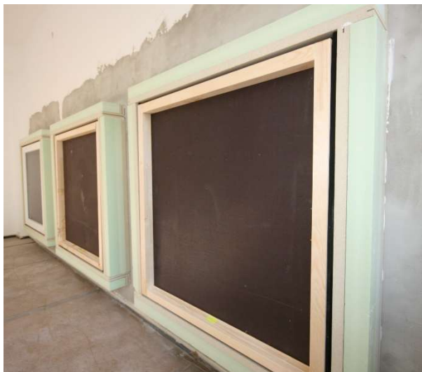
Abbildung 5: Montage von zwei Holz- und einem Kunststoffrahmen im Vorwand-Montagesystem an der Massivwand. Das MFB ist als schwarze Linie in der Fuge zu erkennen.
