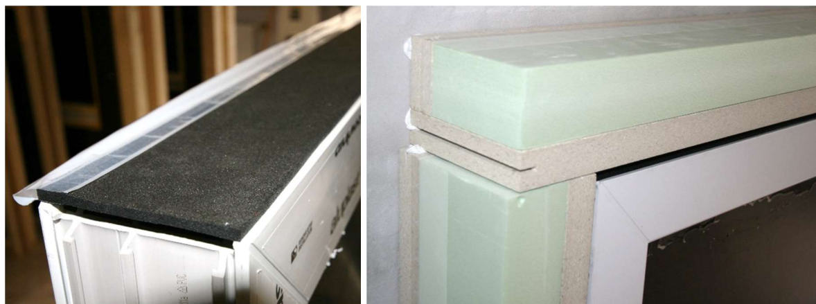
Abbildung 6: Montage des MFB an einem Kunststoffrahmen.
