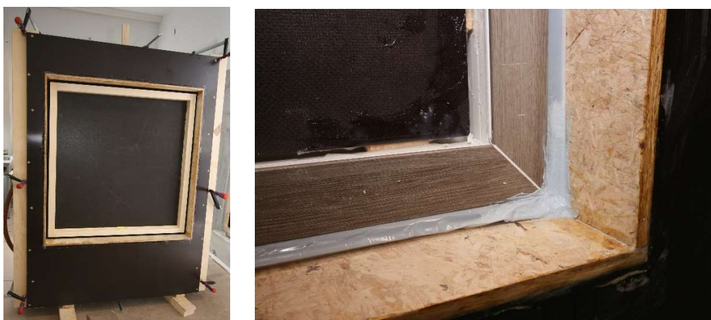
Abbildung 4: Montage eines Holz- und eines Kunststoffrahmens in dem Holzwandabschnitt. Im rechten Bild ist die Eckabdichtung mit der Spritzmasse zu erkennen. Alle verwendeten Blendrahmen wurden anstelle des Flügelrahmens mit einer luftdichten, verklebten Holzplatte verschlossen.
