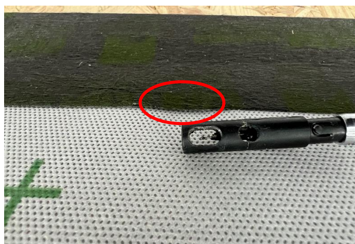
Image 12 : Fuite mesurable à l'aide d'un anémomètre à la jonction entre le pare-vapeur et la bande adhésive avant la finition. Fuite détectable uniquement à des pressions plus élevées.
