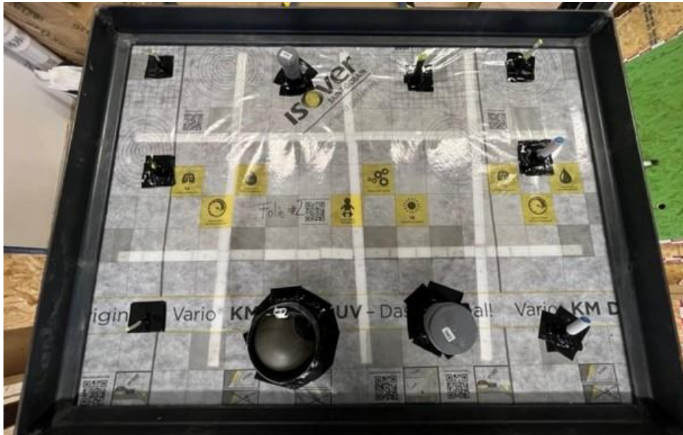
Abbildung 8: Fertig montierte und verklebte Durchführungen auf einer Luftdichtheitsbahn.
