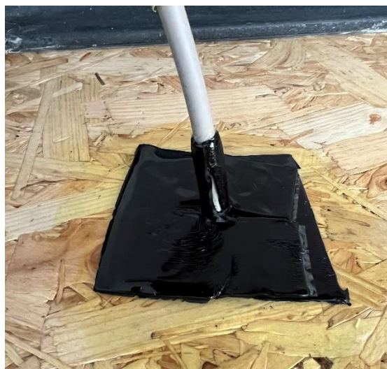
Abbildung 2: Abdichtung eines 3x1,5 NYM-Kabels mit ISOVER Vario® Stretch von zwei Seiten auf einer OSB-Platte.
