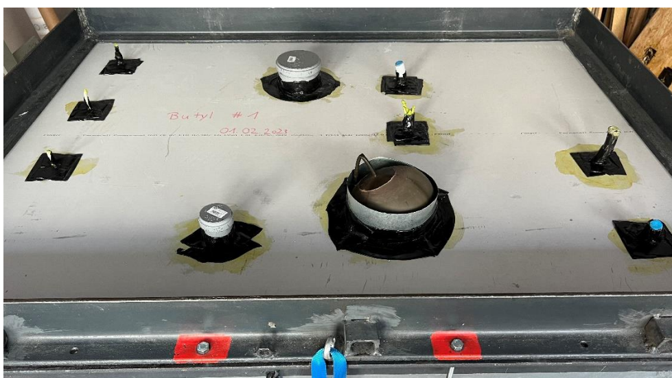
Abbildung 10: Fertig abgedichtete Durchführungen durch eine Betonplatte.
