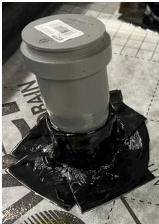
Abbildung 6: Verklebung des HT-Rohrs DN 50 mit ISOVER Vario® Stretch
