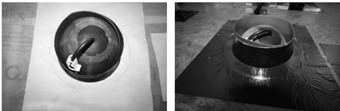
Abbildung 8: Wickelfalzrohr (180 mm) verklebt mit KABSEAL PRO 180-195 (links) und KABSEAL GAS 180-195 (rechts). Für die Messungen wurde das Rohr mit einer Ballblase abgedichtet.
