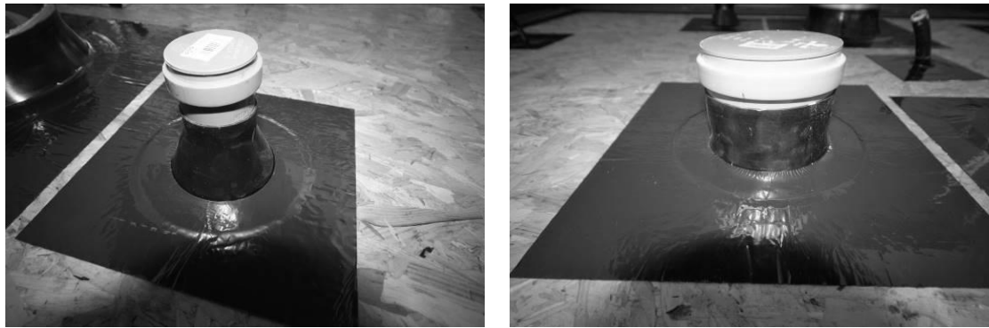
Abbildung 7: Verklebung des HT-Rohrs DN 50 mit der Leitungsmanschette KABSEAL GAS 50-72 (links). HT-Rohr DN 110 verklebt mit der Leitungsmanschette KABSEAL GAS 100-110 (rechts).
