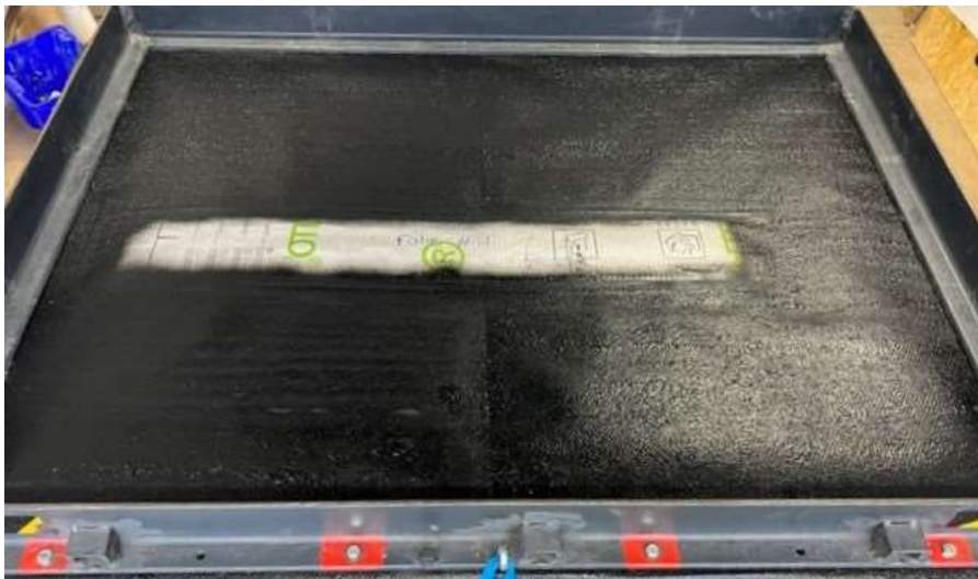
Abbildung 1: Einbindung des Luftdichtheits-Membransystems.
