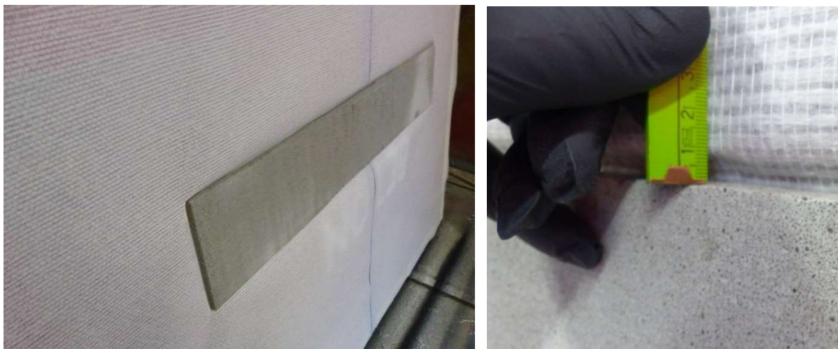
Abbildung 4: Eingesetzte Betonfläche (links) und Größe des verbleibenden Spalts (rechts).
