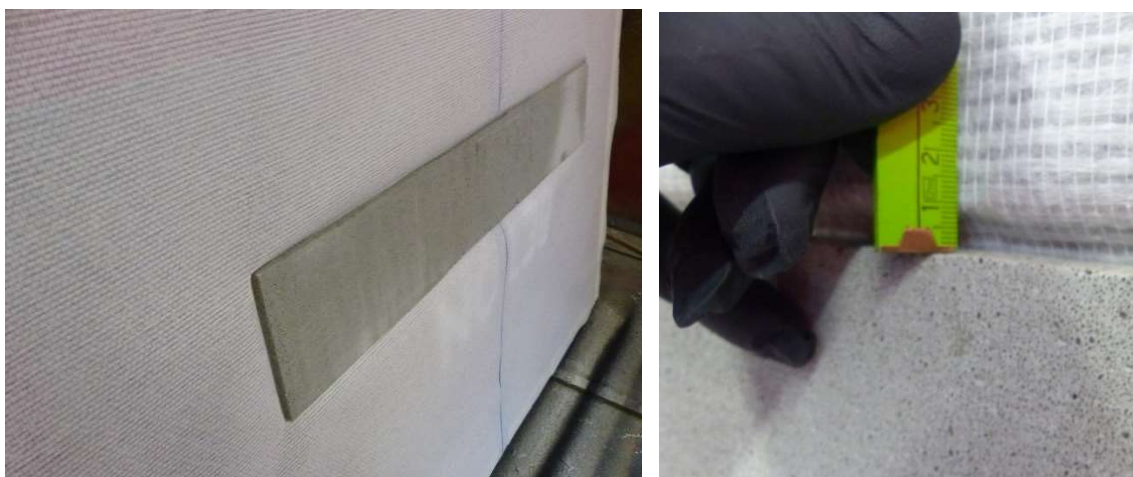
Illustration 4 : Surface en béton posée (gauche) et taille de l'interstice restant (droite).
