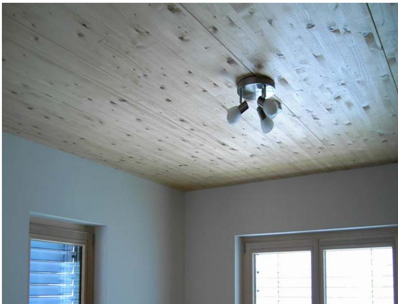
Die Decken der Räume im Erdgeschoss und Obergeschoss wurden als sichtbare Brettstapelkonstruktionen erhalten, da die Decken eine sehr angenehme und warme Stimmung erzeugen.
