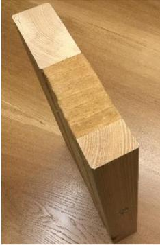
**Insulation column of the external wall / Dämmständer der Außenwand**
