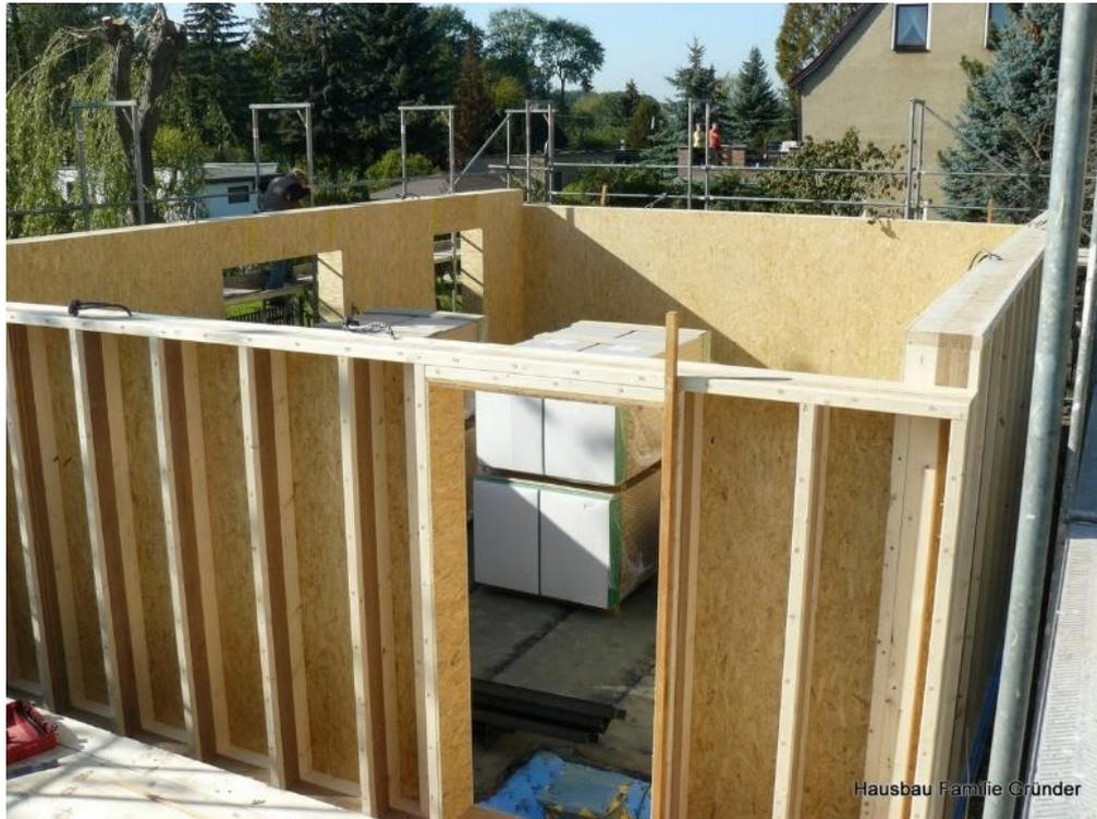
**External walls in bare brickwork (insulating columns) / Außenwände im Rohbau (Dämmständer: <https://www.kmh-bausysteme.de/elemente/wand-pn-daemmstaender.html>)**
