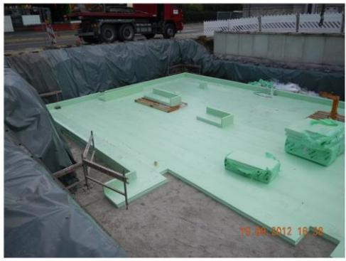
**Dämmung unter der Bodenplatte (Flachgründung).**
