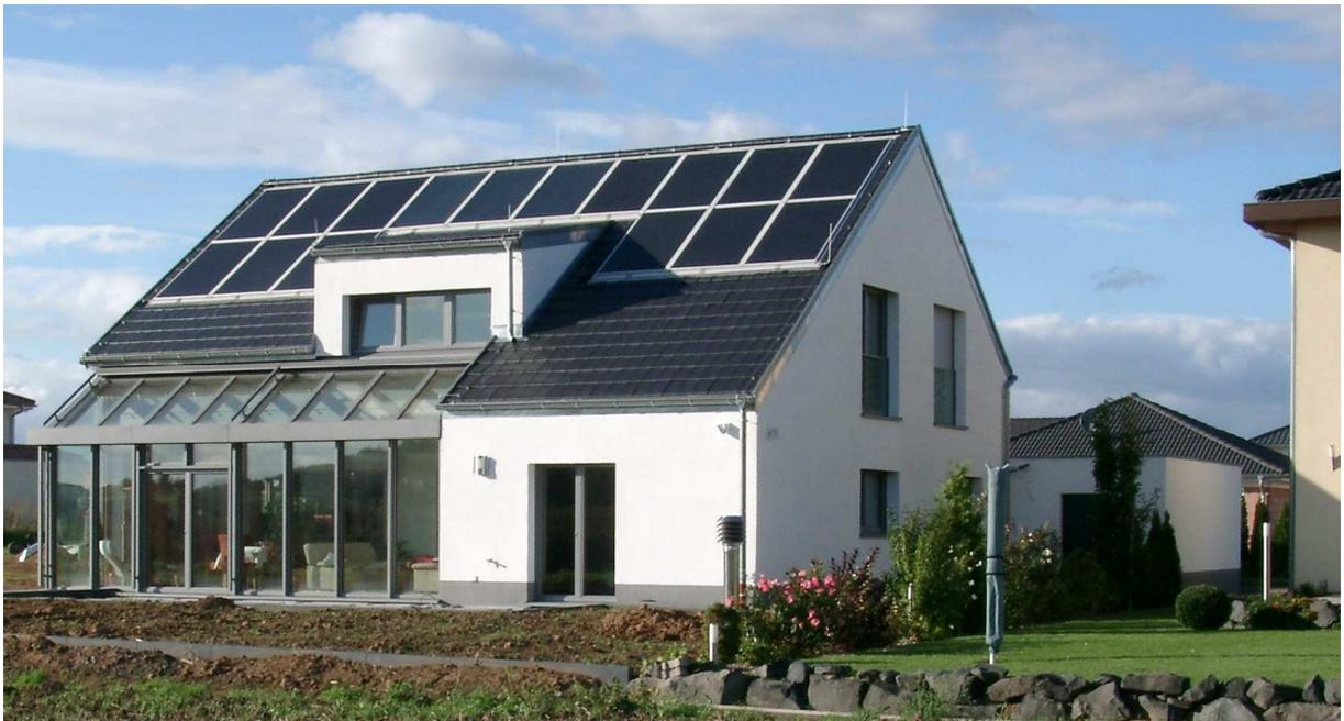
**Südostseite:** Ebenfalls zu sehen sind die Luftansaugung Erdwärmeregister und Solarthermie- und Fotovoltaik-Indachanlage
