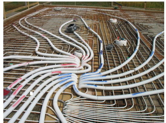
12. Abbildung Luftkanäle innerhalb der thermischen Hülle
