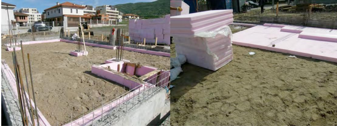
Wie bereits im Schnitt gezeigt, alle vertikalen Wände der Einzel- und Streifenfundamente sind mit XPS gedämmt. Auf der gleichen Art und Weise ist die Unterseite der der Betondecke des EG gedämmt. Die Fotos zeigen die Ausführung.
