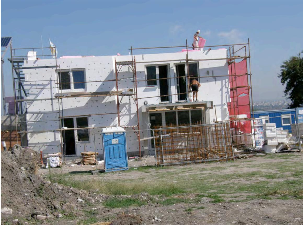
**Die Außenwände des Gebäudes sind aus Stahlbeton mit Dicke 20 cm ausgeführt, mit zweischichtiger Dämmung mit Dicke 26 cm. Die erste Schicht (18 cm) ist auf den Wänden geklebt und die zweite Schicht mit Dicke 8 cm ist auf der ersten Schicht geklebt. Die Fotos zeigen die Ausführung.**
