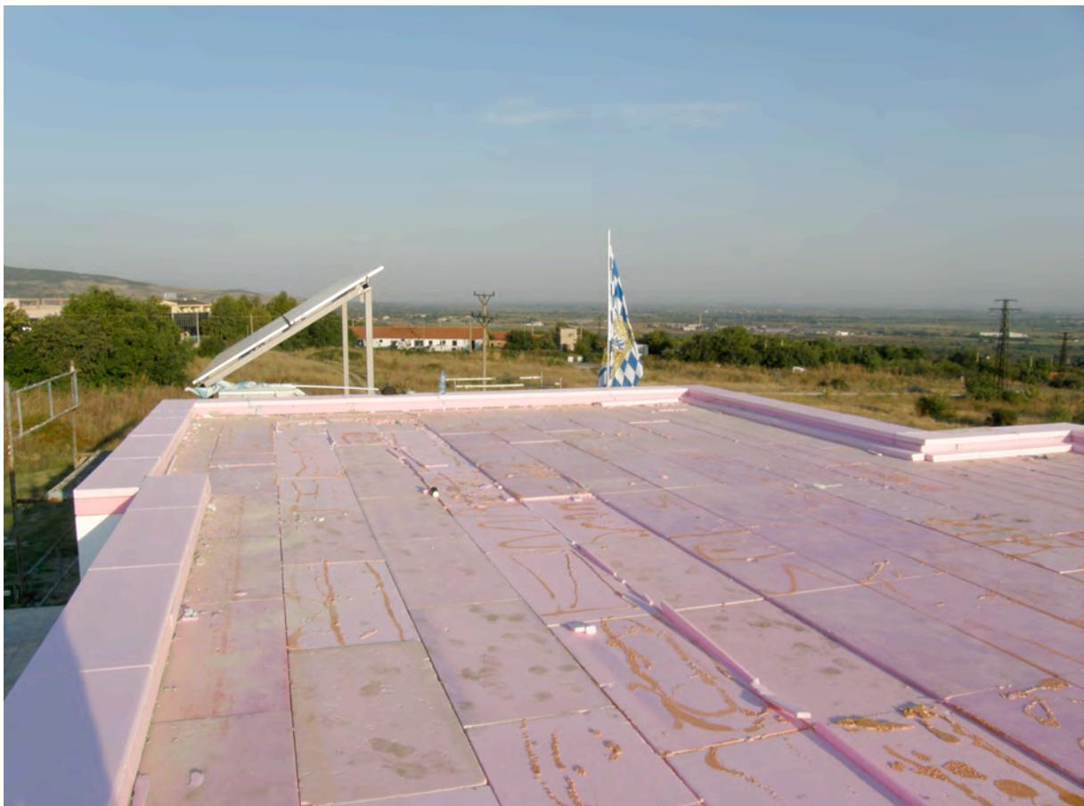
Der Dachaufbau des Passivhaus OKB Markovo.
