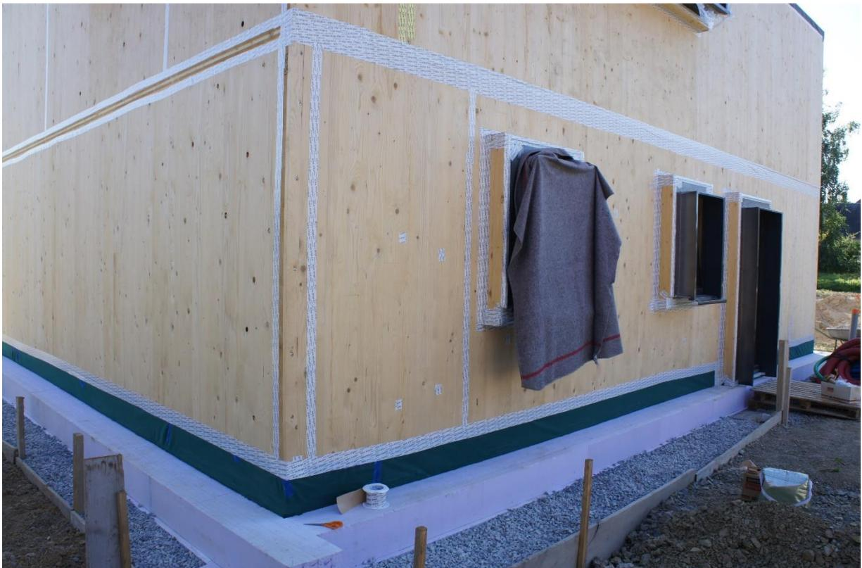
Membrane d'étanchéité à l'air Proclima DA scotché sur le mur en bois massif
