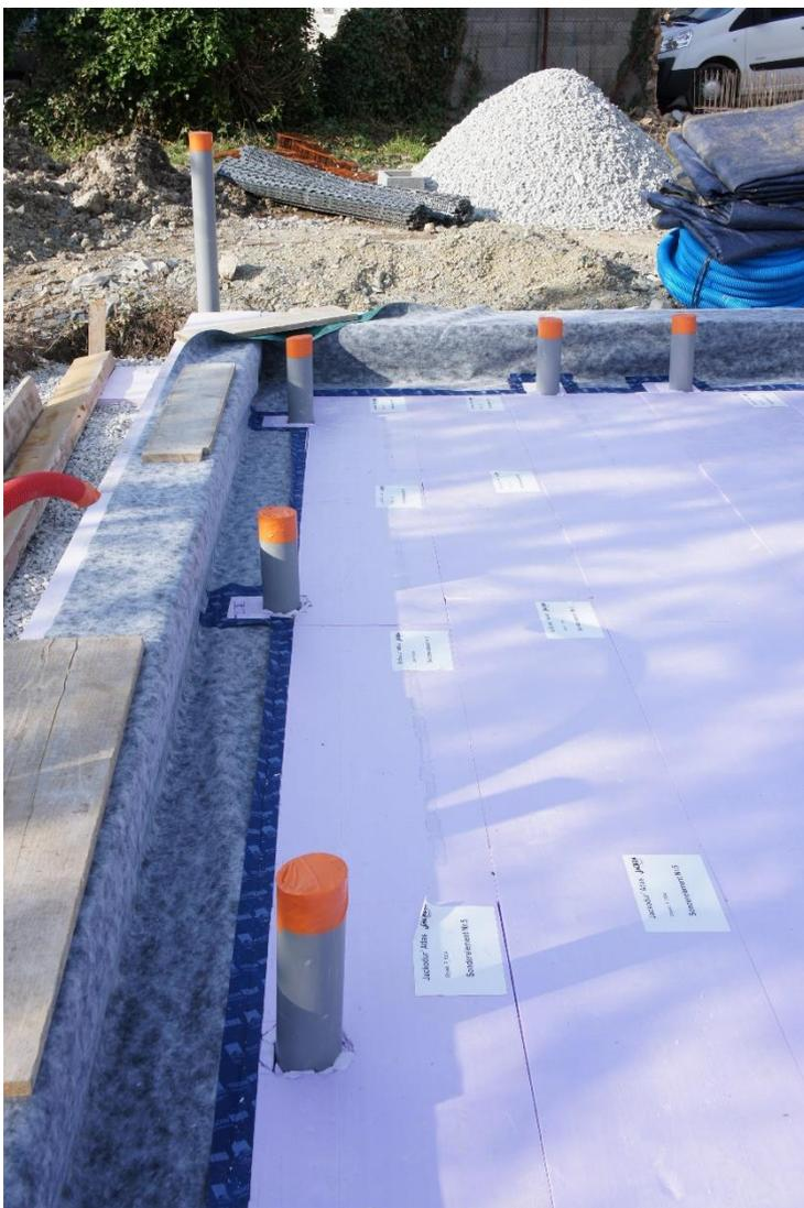
Membrane d'étanchéité à l'air Proclima DA scotché sur l'isolation en XPS
