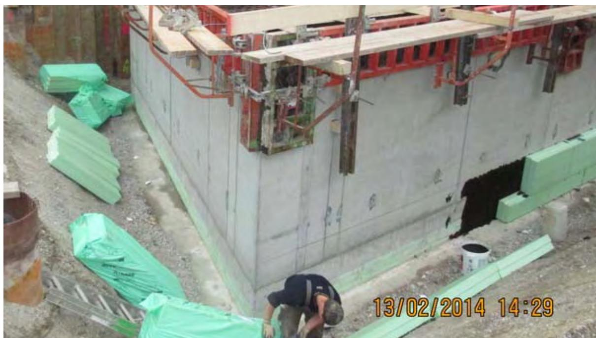
*Ausführung Kellerwand / Bodenplatte mit Dämmung*
