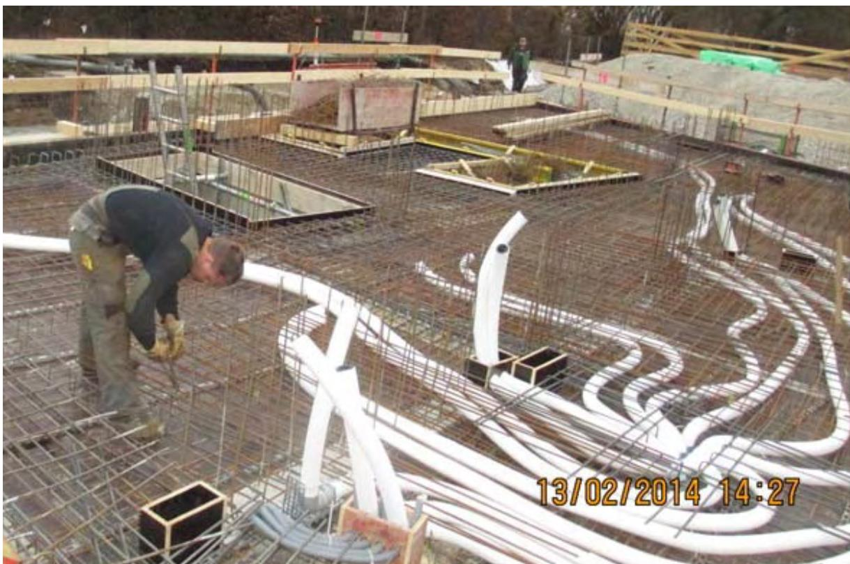
*Verlegung Lüftungsleitungen in Bodenplatte OG/ Deckenplatte EG*
