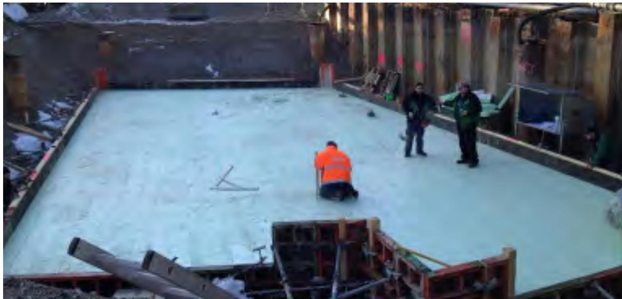
*Ausführung Bodenplatte mit Dämmung*
