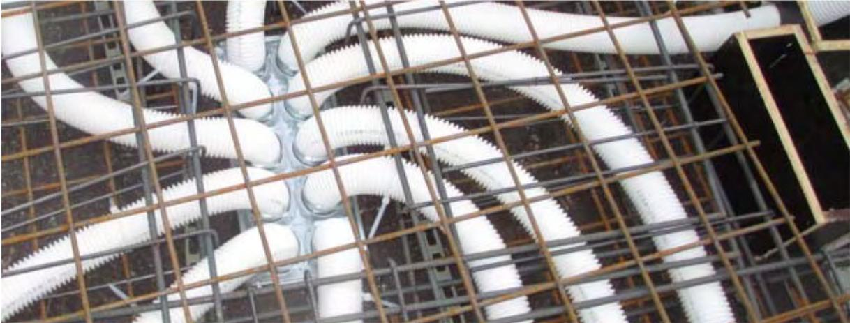
*Verlegung Lüftungsleitungen in Deckenplatte EG während Platzierung Bewehrungsseisen*
