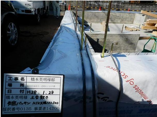
Dichtungsmaterial zwischen Fundament und Außenwand
