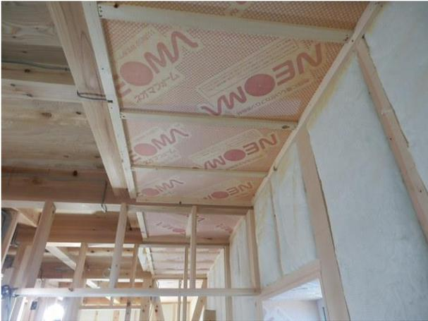
Wärmebrückereduzierung mit Innenwärmedämmung
