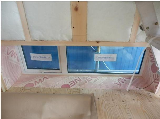
Wärmebrückenreduzierung mit Innenüberdämmung
