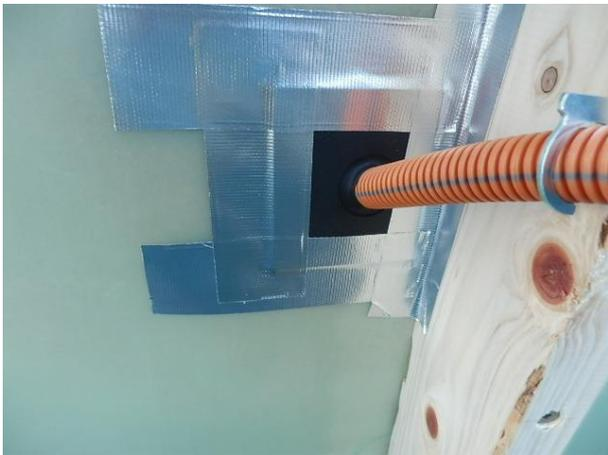
Luftdichtung aus Gummi für Rohr
