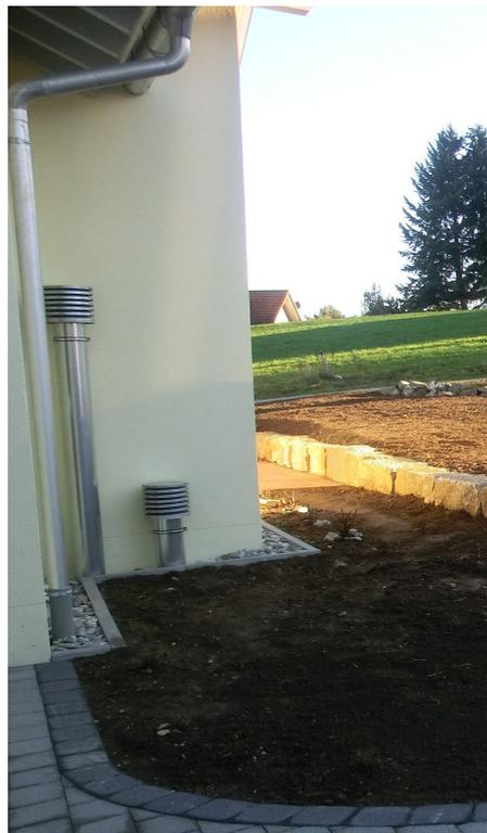
Das Gebäude wird über die Anlage aeronom WS 250 der Firma Maico mit einem Wärmebereitstellungsgrad von 85% und einer Stromeffizienz von 0,35 W/m³h mit Frischluft versorgt. Die Frostfreihaltung wird über Erdwärmekörbe gewährleistet. Die Frisch- und Fortluftkanäle sind dampfdiffusionsdicht gedämmt.
