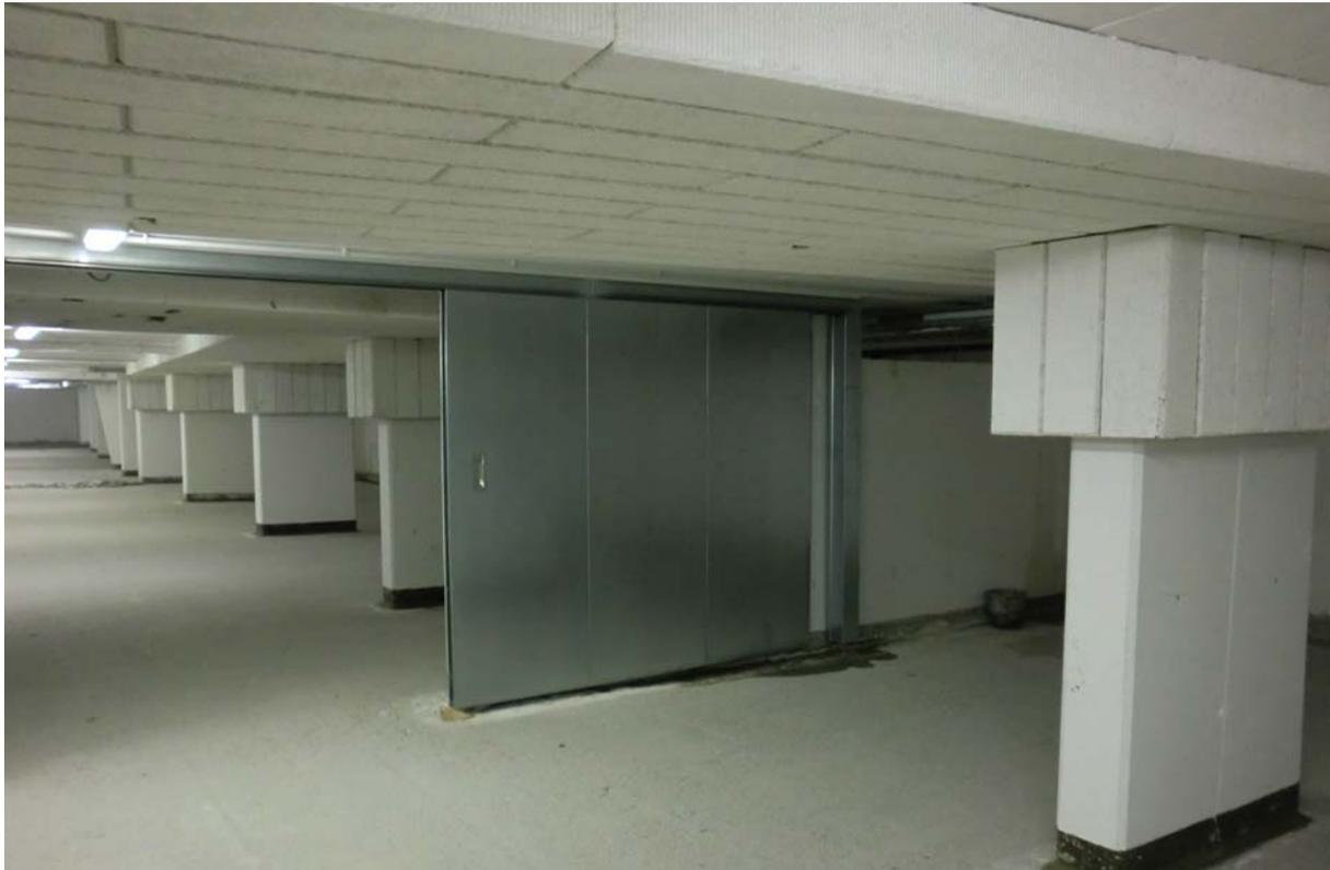
**Studierenden-Wohnheim GreenHouse, 2.Untergeschoss.** An der Decke und an den Säulen ist die Flankendämmung erkennbar. (Foto: aap.architekten)
