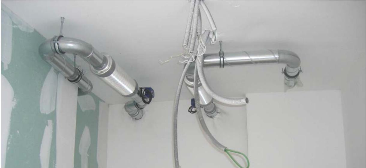
**Studierenden-Wohnheim GreenHouse, Lüftungsführung Badezimmer.** Führung Luftleitungen in der abgehängten Decke des Badezimmers in Wickelfalzrohren. Erkennbar sind die Schalldämpfer und die Volumstromregler, am Rohrende des rechten Rohres ist die Folie sichtbar mit der die Lüftungsleitungen bis zur Komplettierung mit den Lüftungsgittern verschlossen waren. (Foto: aap.architekten).
