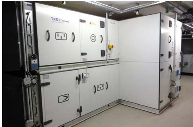
**Studierenden-Wohnheim GreenHouse, Lüftungsgerät.** Außenansicht Lüftungsgerät TROX X-CUBE – Rotationswärmetauscher. (Fotos: aap.architekten).
