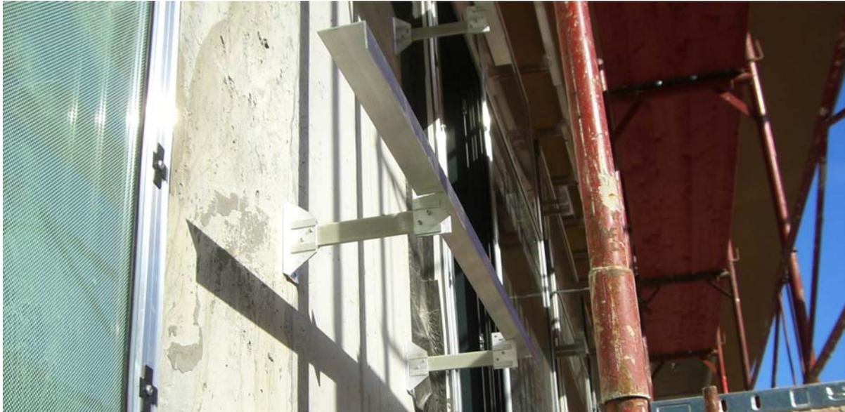
**Studierenden-Wohnheim GreenHouse, Montage vorgehängte Fassade.** Die thermische Trennung der Montageanker wird durch einen eingesetzten Kunststoffsteg hergestellt. (Foto: aap.architekten).
