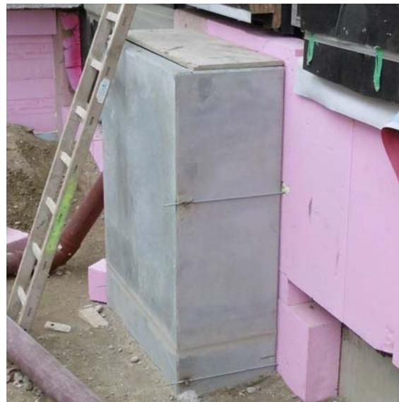
**Studierenden-Wohnheim GreenHouse, Perimeterdämmung.** Anschlussbauteile wie Lichtschächte wurden thermisch getrennt, die Perimeterdämmung geht durch. (Foto: aap.architekten).
