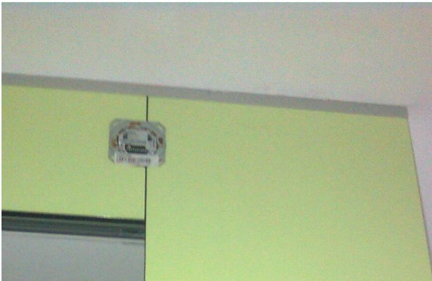
**Studierenden-Wohnheim GreenHouse, CO2 Sensor.** Die CO2 Sensoren wurden in den Studentenzimmern an der Trennwand zum Bad in Deckennähe montiert. Das Foto zeigt einen Sensor ohne Abdeckung. (Fotos: aap.architekten).
