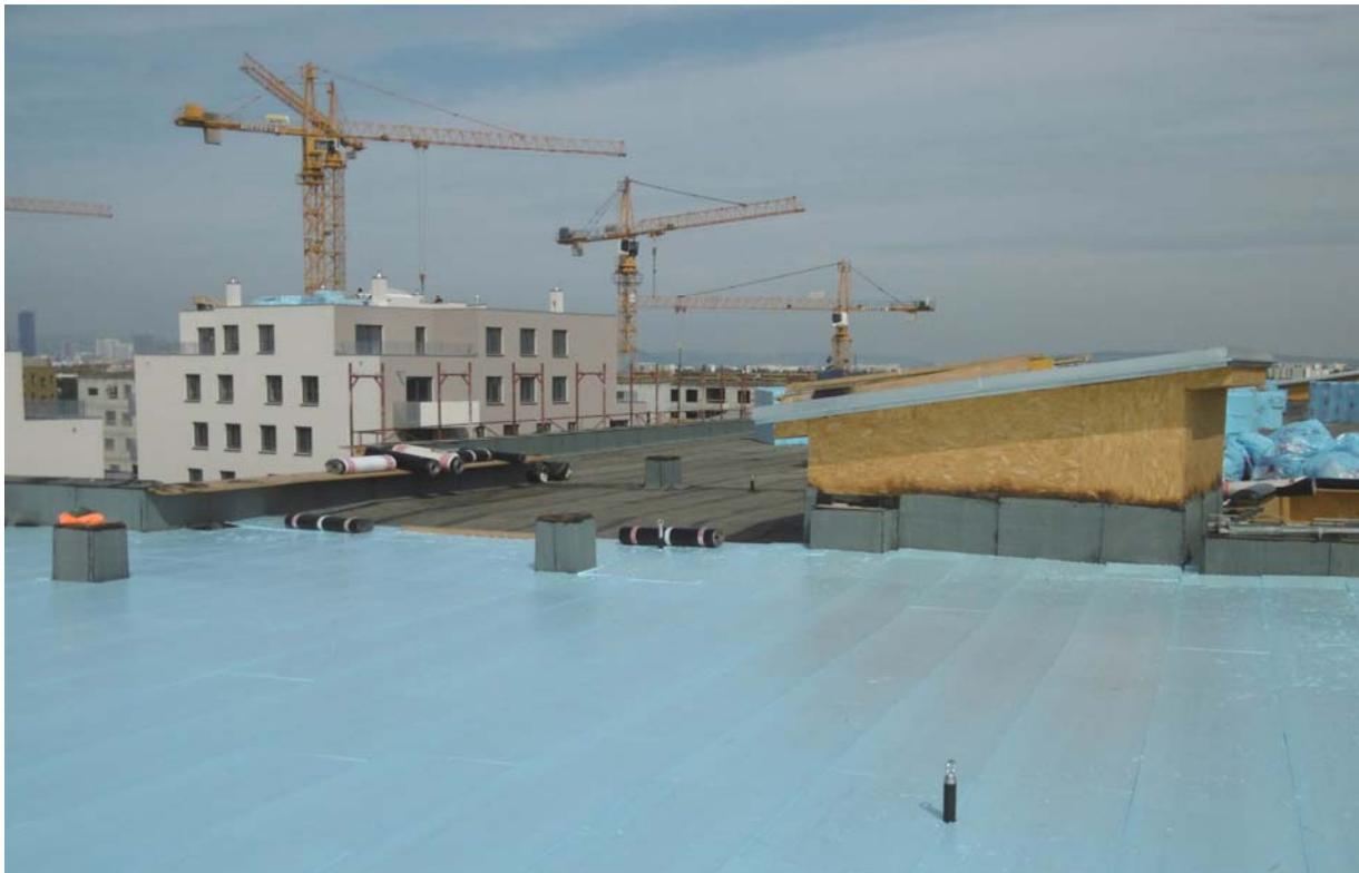
**Studierenden-Wohnheim GreenHouse, Gefälledämmung Dach.** Im Vordergrund sind zwei Einhausungen der Fallstrangüberlüftungen, dahinter die Liftüberfahrt zu erkennen. Die Überlüftungen der WC-Rohre sind in Österreich über Dach zu führen, der Einsatz von Kanalüberlüftungen mit Aufsatzelementen ist normativ nicht zulässig. (Foto: Porr).
