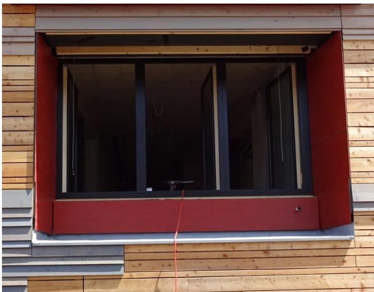
Ansicht Kräuterkistl mit fertig hergestellter Plattenverkleidung auf den Seitenwänden.
