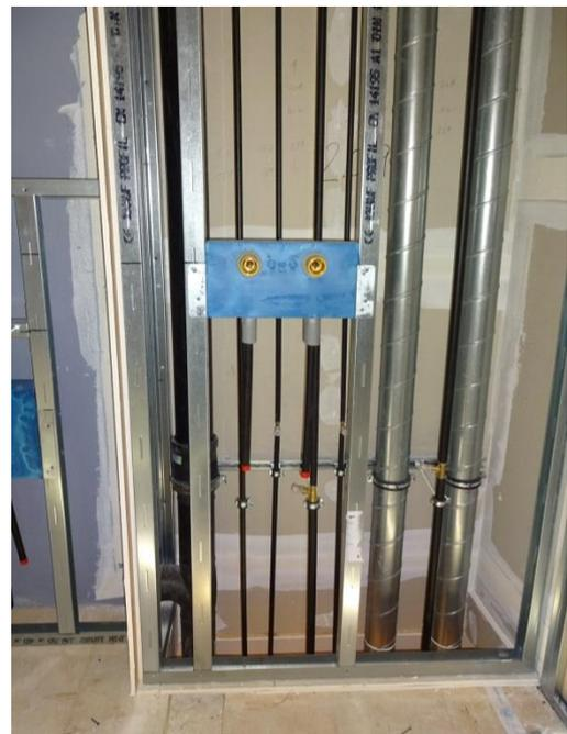
**Studierenden-Wohnheim mineroom, Installationsschacht Bewohnerzimmer.** Auf dem linken Bild ist die Brandschutzverkleidung des Schachtes auf den Wänden aus Brettschichtholz zu sehen. Diese Verkleidung wurde auch im Bereich des Deckendurchbruches hergestellt, wo das Brandschott zwischen den Geschossen eingebaut wird. Auf dem rechten Bild ist die noch ungedämmte Rohinstallation des Schachtes bereits montiert. (Fotos.: aap.architekten)
