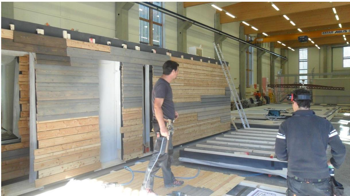
**Studierenden-Wohnheim mineroom, Fertigung Außenwandelemente.** Die Anschlusslaschen der Folien zur Herstellung der Luftdichtheit sind an den Elementen erkennbar.
