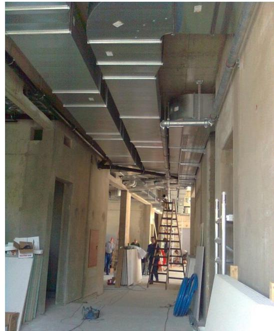
**Studierenden-Wohnheim mineroom, Hauptlüftungsstränge Erdgeschoss und Verteilung der Luftleitungen an der Decke EG.** Auf dem linken Bild sind die Brandschutzklappen der Luftleitungen zu sehen. Die Brandschutzverkleidung des Schachtes ist noch nicht hergestellt.
