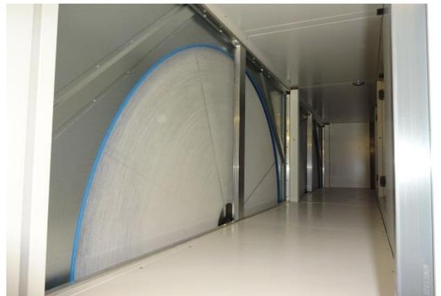
**Studierenden-Wohnheim mineroom, Lüftungsgerät TROX X-CUBE und Rotationswärmetauscher.**
