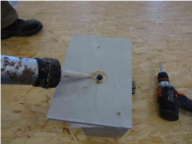
5. An der Außenseite (Raffstoreschacht) wird die Gipsfaserplatte mit einer im Vorhinein hergestellten Bohrung (DM 40mm) aufgebracht.
