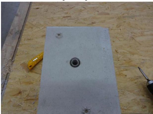
4. Einbauen der Leerverrohrung und Herstellen der Abdichtung zwischen Vliesdampfbremse und Leerverrohrung mittels Airstop-Dichtmasse-Sprint.
