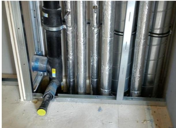
**Studierenden-Wohnheim mineroom, vertikale Verteilung der Obergeschosse.** Auf dem linken Bild sind Rohrdämmungen mit Alukasierung zu sehen. Deutlich erkennbar ist das Verhältnis von Rohrdurchmesser zu Dämmdicke. Auf dem rechten Bild sind bereits gedämmte Leitungen in den Schächten zu sehen. (Fotos.: aap.architekten)
