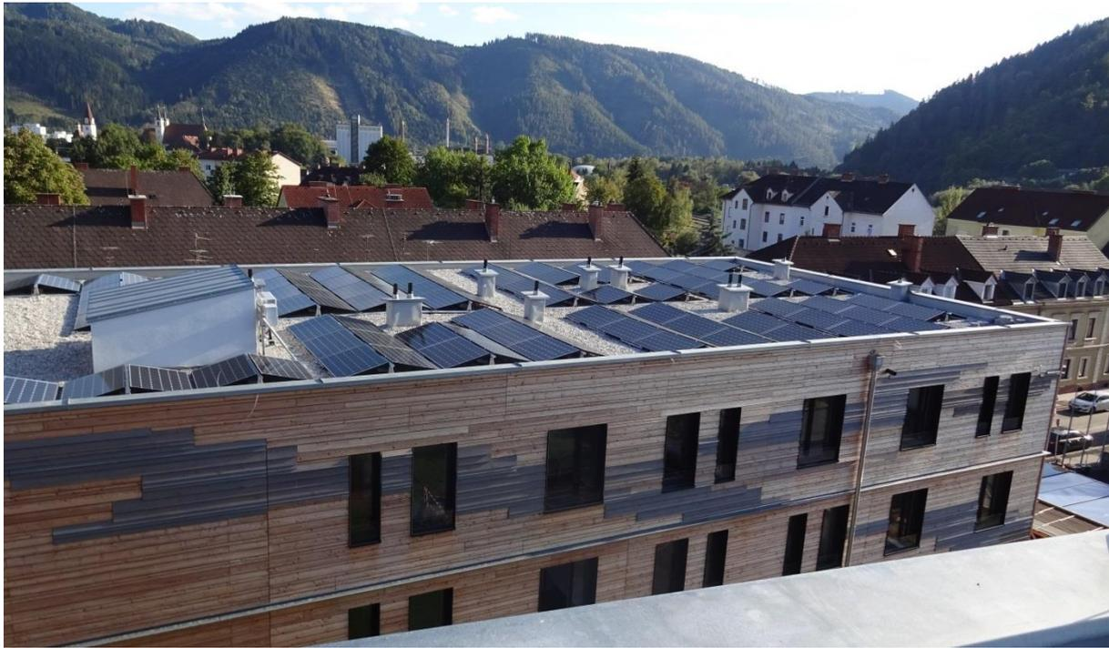
**Studierenden-Wohnheim mineroom, PV Anlage.** Die Photovoltaikmodule wurden mittels einer Unterkonstruktion auf dem Dach aufgestellt und mit Auflast gegen Abheben gesichert. Dadurch ist keine Durchdringung der Abdichtungsebene erforderlich. (Foto: aap.architekten)
