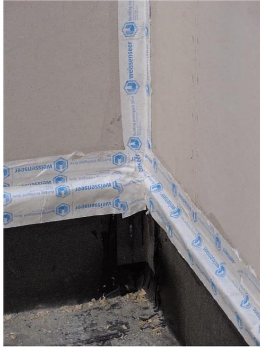
**Studierenden-Wohnheim mineroom, Sockel Anschluss aufgesetzte Holzwand.** Hochzug Perimeterdämmung bis OK Bodenplatte (die Dämmung Sockel fehlt hier noch) und Abklebung zum Sockel Innen (Fotos: Swietelsky und aap.architekten)
