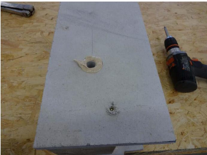
7. Aufbringen der Fassadenbahn. Die Verklebung der Fassadenbahn mit der Leerverrohrung erfolgt durch die darunterliegende Klebewulst.
