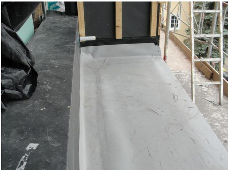
Fertig hergestellte Abdichtungsebene auf der Wärmedämmung als Foliendach.
