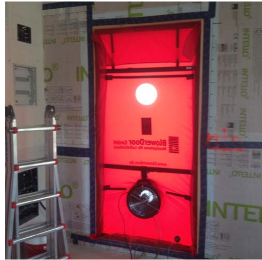
Blower door test
