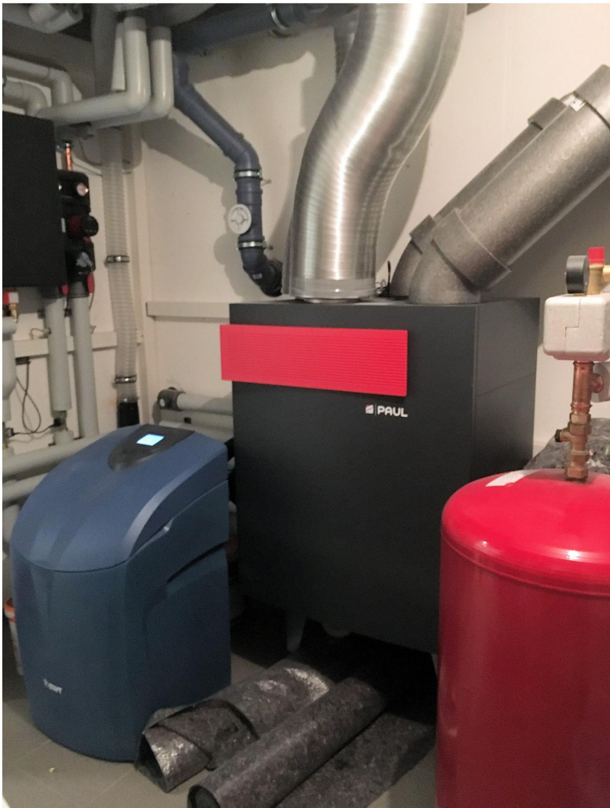
Lüftungsgerät Fabr. Paul zwischen Entkalkungsanlage und Ausdehnungsgefäß der Heizung
