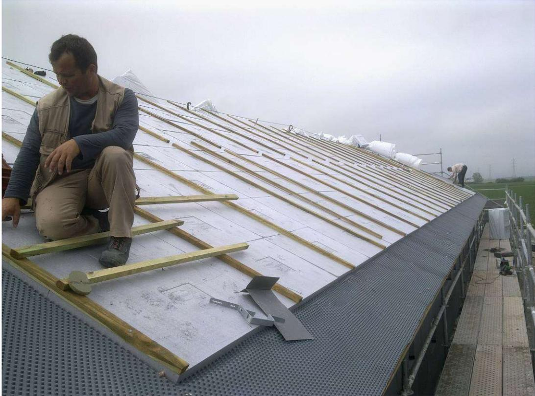
2012/05/18: Colocación de aislamiento, rastrel y lámina antinieve en cubierta
