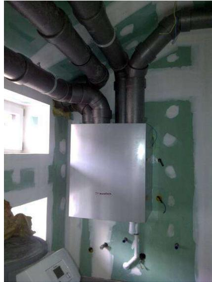
Máquina de la VMC en el cuarto de instalaciones incluso todos los tubos de la instalación
