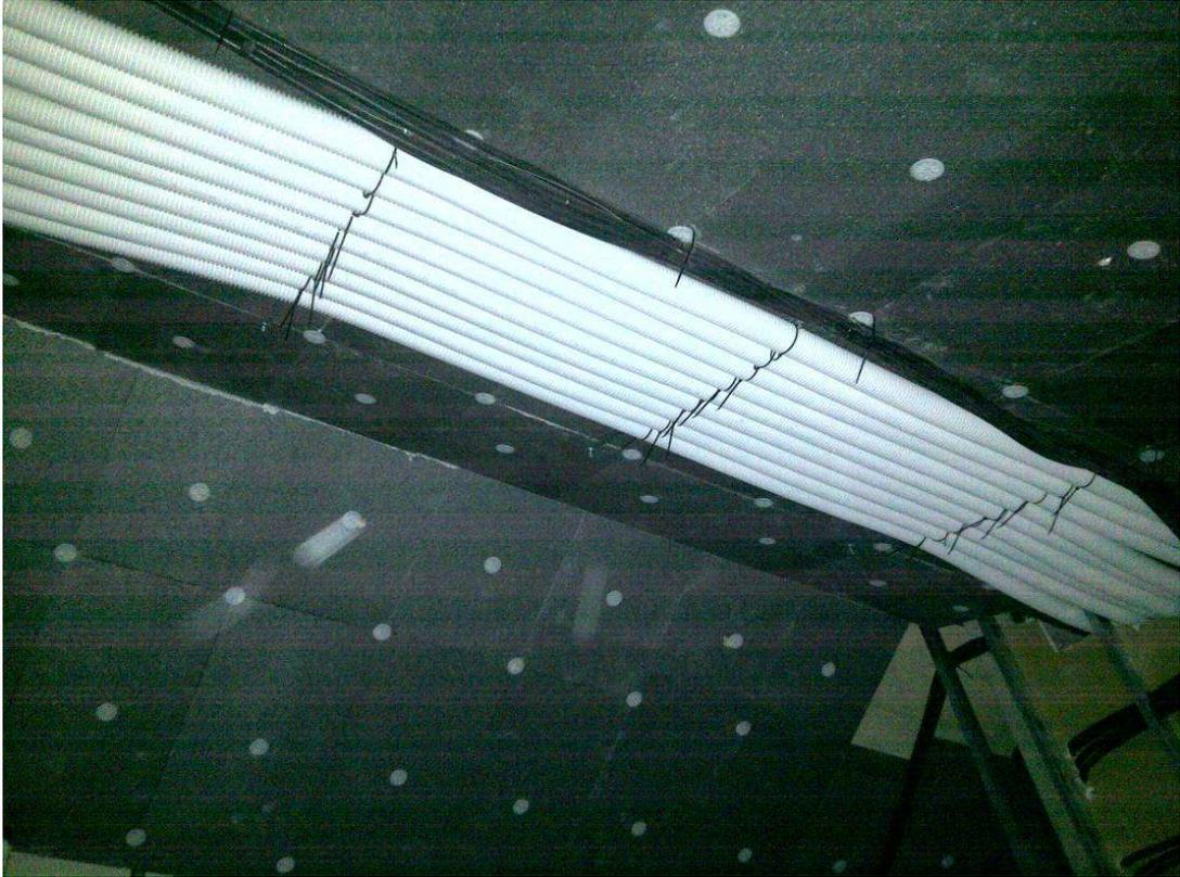
2012/06/16: Trazado de tubos de la VMC entre Neopor y falso techo
