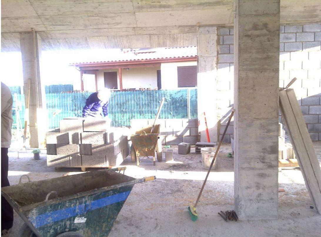
2012/03/27: Inicio trabajos de cierre de fachada con bloque de hormigón aligerado con arlita
