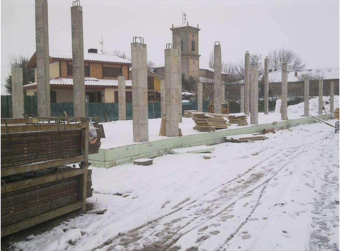
2012/02/08: Pilares ejecutados y aislamiento de losa visible
