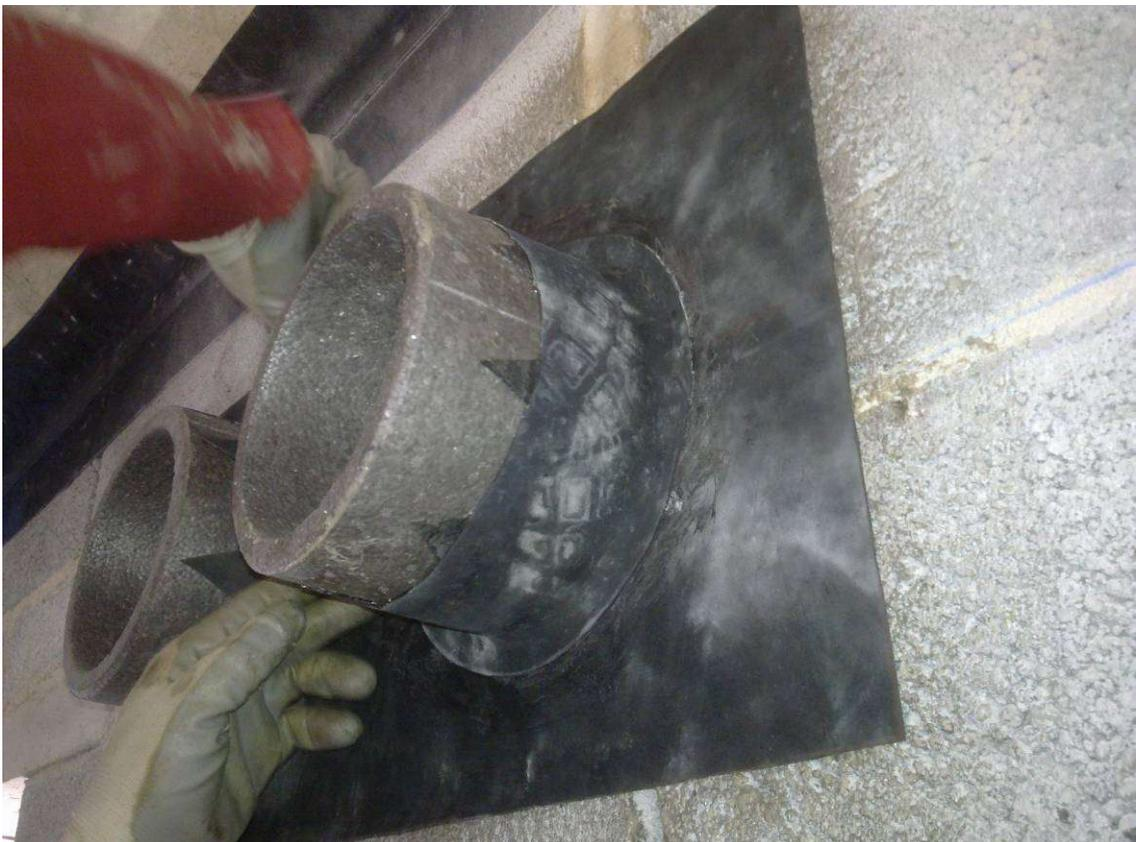
2012/05/11: Sellado de tubos de entrada y salida de aire de la VMC y aerotermo
