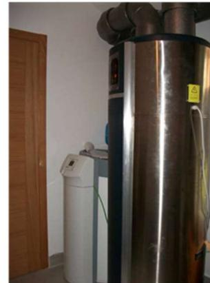
Fig. 2: solar y aerotermo.
