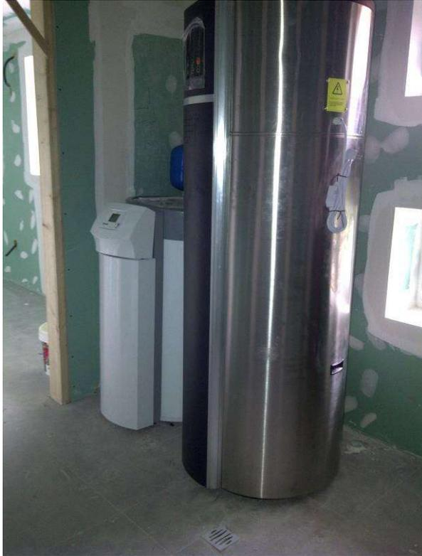
2012/07/05: Depósito solar, aerotermo y vaso de expansión en sala de instalaciones
