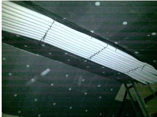
Colocación de conductos de ventilación, impulsión y extracción, previa ejecución del falso techo de cartón-yeso
