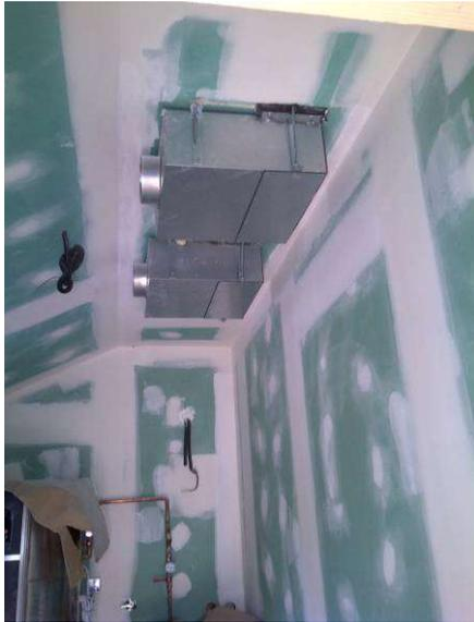
Colectores y silenciadores de impulsión y extracción en cuarto de instalaciones.
