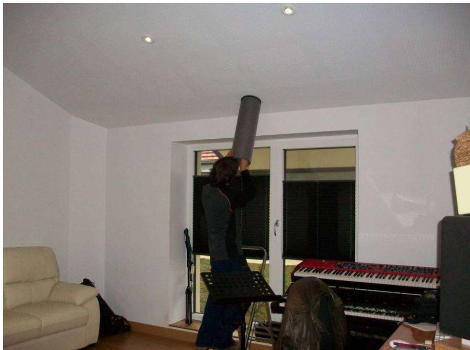
Medición de caudal y velocidad de la VMC en el estudio para su calibración.
