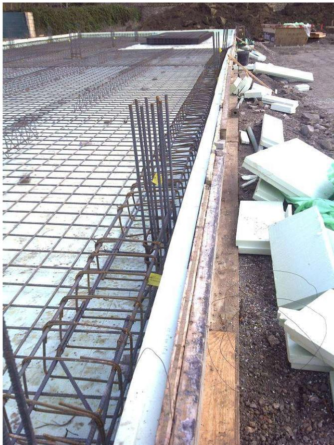
2012/01/22: Aislamiento con XPS 8 cm en borde de losa
