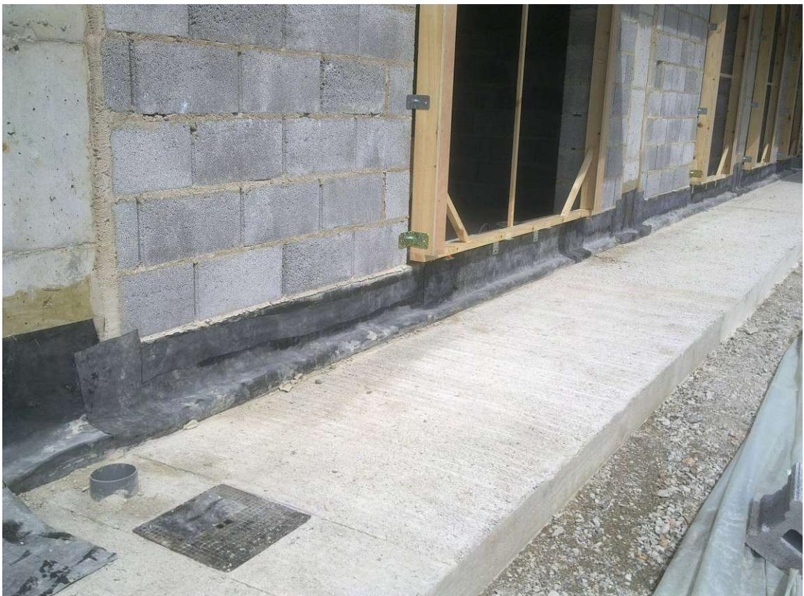
2012/04/13: Colocación de premarcos de madera impermeabilización de frentes
