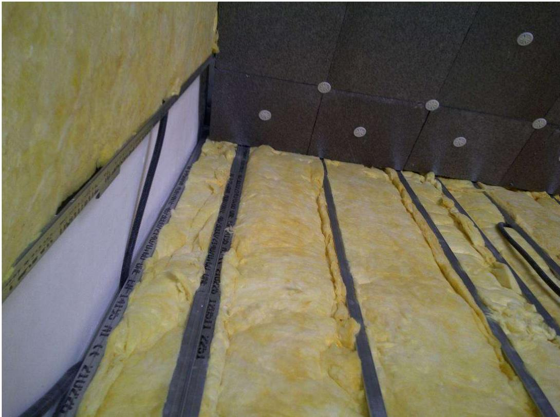
2012/06/15: Neopor interior de cubierta y trasdós con manta para paso de instalaciones
