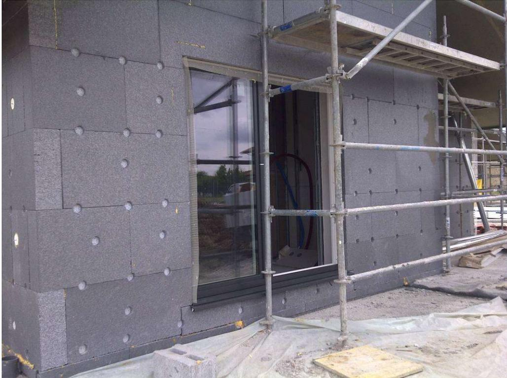
2012/06/06: Colocación de tacos de PVC para sujeción del SATE
