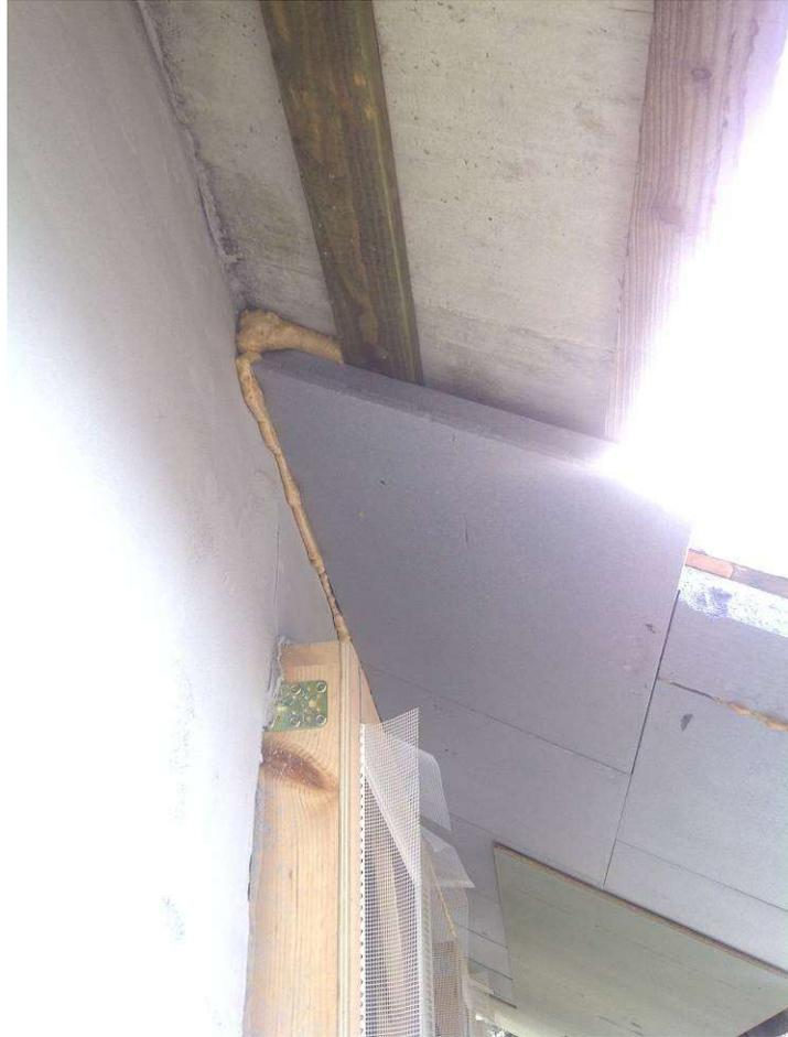
2012/04/27: Colocación de aislamiento bajo el vuelo para una envolvente térmica continua
