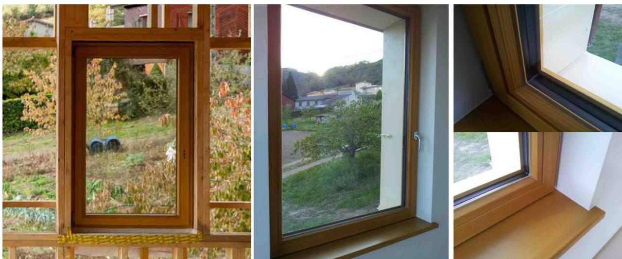
*Menuiserie posée en attente contreventement, frein vapeur et pare pluies et isolation / avec tablette, jouées, tableau / bord chaud / tablette*
